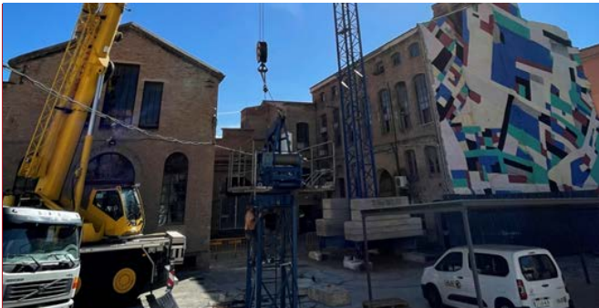
Obres de rehabilitació de l'Anònima Font: Ajuntament de Manresa
