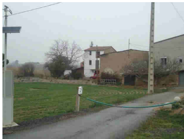
Detall camí entrada casa. Panell fotovoltaic.
