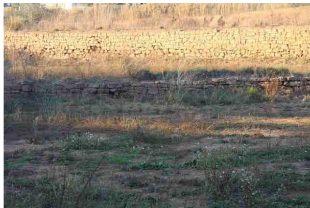
Mur de pedra seca
