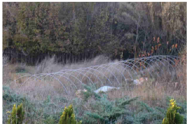
Estructura de hivernacle abandonada
