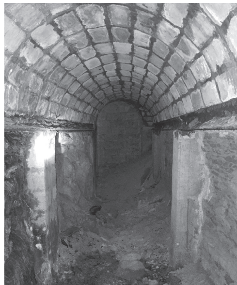
Galeria del refugi antiaeri de la Renfe l'any 2019 (Ajuntament de Manresa)
