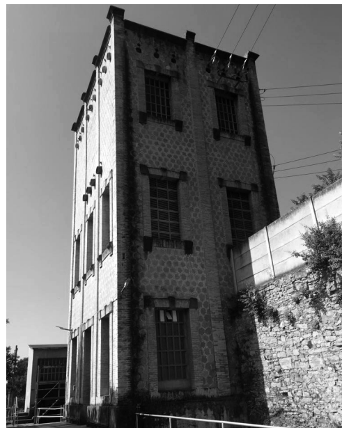
Torre-transformador de 1931 (Ajuntament de Manresa)
