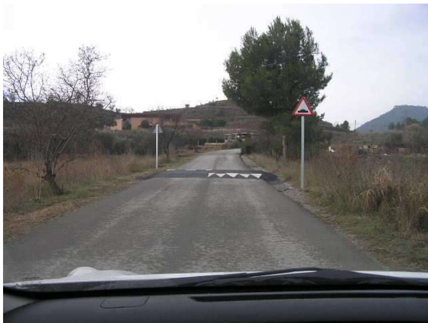
Pas elevat en camí rural pavimentat
