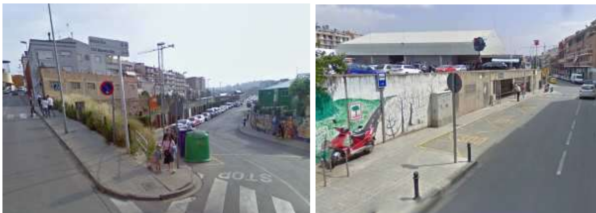
Estació Manresa Alta
