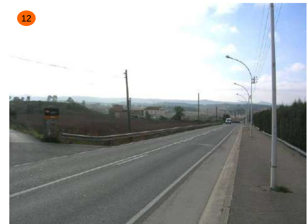
Carretera d'Igualada, al nord de les Vivendes Pare Ignasi i Puig. La rectitud de la carretera incita a velocitats excessives. La ubicació dels fanals resta amplada lliure de la vorera, que en principi és força àmplia.
