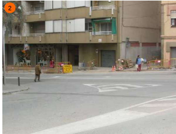
Via Sant Ignasi, intersecció amb el carrer Vidal i Barraquer. No hi ha cap pas de vianants per a creuar la via Sant Ignasi.
