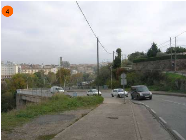
Carretera d'Igualada, pujada des del pont Sant Francesc. El pendent i les corbes comporten la dificultat d'anar ràpid sense envair el carril contrari. Comença un canal de desguàs ubicat entre la vorera i la calçada.
