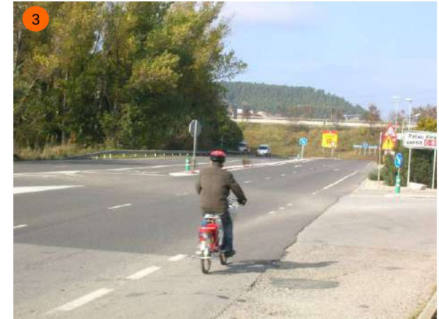
Carretera de Solsona, accés a Miralpeix. Hi ha un carril de gir per accedir a la barriada i la benzinera i un altre carril d'incorporació per als vehicles que surten de la barriada. Hi ha senyals que queden tapats per altres senyals.
