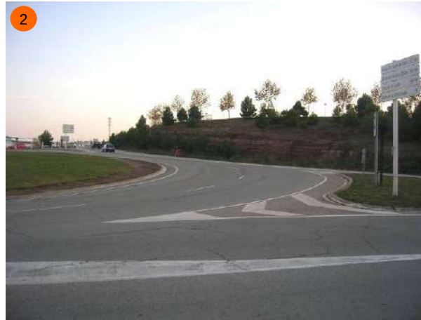
Carrer d'Alvar Aalto, entrada a la rotonda. Un dels dos carrils no entra a la rotonda i es dirigeix directament al branc sud. L'altre carril sí entra a la rotonda però en línia gairebé recta (incita a entrar amb massa velocitat).
