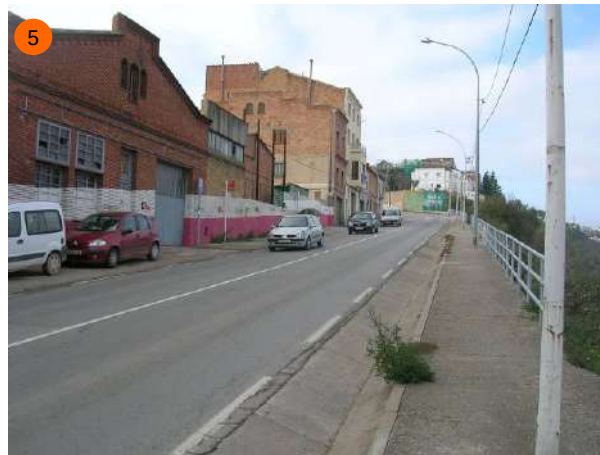
Carretera d'Igualada, pujada des del pont Sant Francesc. No hi ha cap separació entre el canal i la calçada. Qualsevol sortida de la calçada, encara que sigui molt petita, provocarà fàcilment un accident greu.
