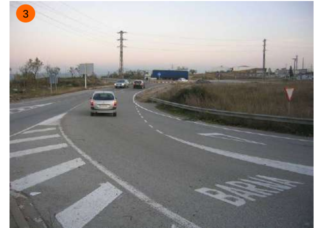
Branc est. El carril de sortida de la rotonda s'uneix amb el carril drecera que ve des del branc sud sense entrar a la rotonda. Als dos carrils la curvatura és molt oberta i això permet velocitats elevades (per tant, l'enllaç resulta perillós).
