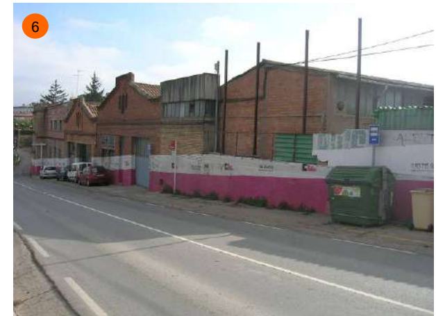
Carretera d'Igualada, pujada des del pont Sant Francesc. En aquest tram hi ha, excepcionalment, voreres als dos costats. Gran part de la vorera sud és ocupada per cotxes aparcats i contenidors de brossa. No hi ha cap pas de vianants entre la vorera principal i la parada de l'autobús.
