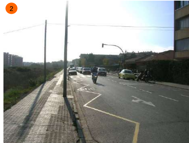
Carrer Pau, a l'oest del carrer Santa Joaquina. A prop de l'entrada del col·legi hi ha un pas de vianants per a creuar el carrer Pau. No s'ha eixamplat el pas amb orelles.
