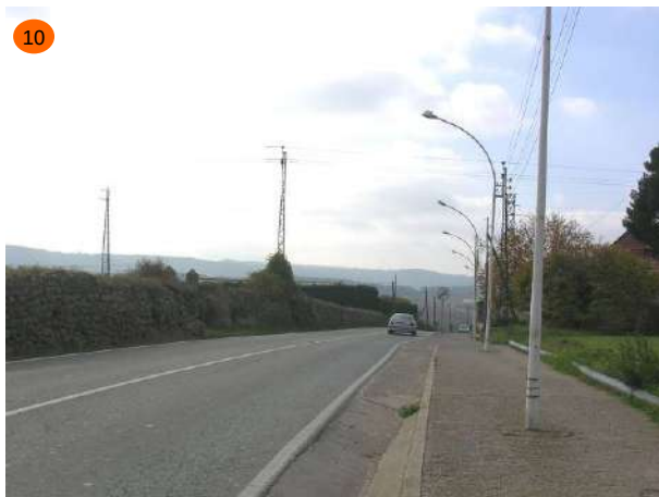
Carretera d'Igualada, final del pendent. Comença un petit tram sense canal de desguàs. Acaba la prohibició d'avançament.
