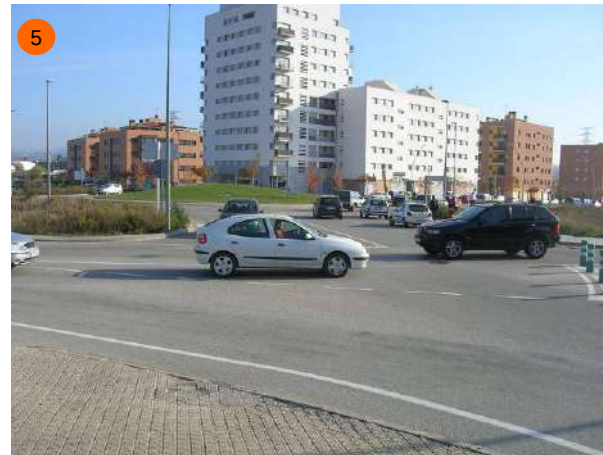
Carrer Santa Joaquina, intersecció amb l'enllaç que connecta amb la ronda Nord. Els vehicles provinents d'aquesta última via disposen d'un carril de gir molt curt per girar a l'esquerra. Per tant, sovint hi ha cues.
