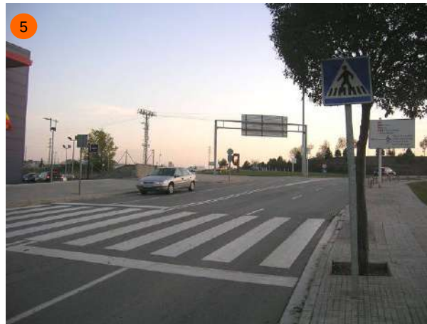
Avinguda Països Catalans. És l'únic dels quatre brancs on el carril drecera té continuïtat i no implica un enllaç perillós entre carrils. L'existència de quatre carrils de trànsit dificulta l'encreuament del pas de vianants, que no disposa de refugi.
