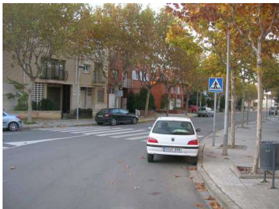
Imatge 24. Passeig de Joan Miró, intersecció amb carrer Puig i Cadafalch. Els passos de vianants no tenen refugi, ni orelles, i els cotxes aparcats perjudiquen clarament el contacte visual entre els vianants i els conductors, que surten de la rotonda.
