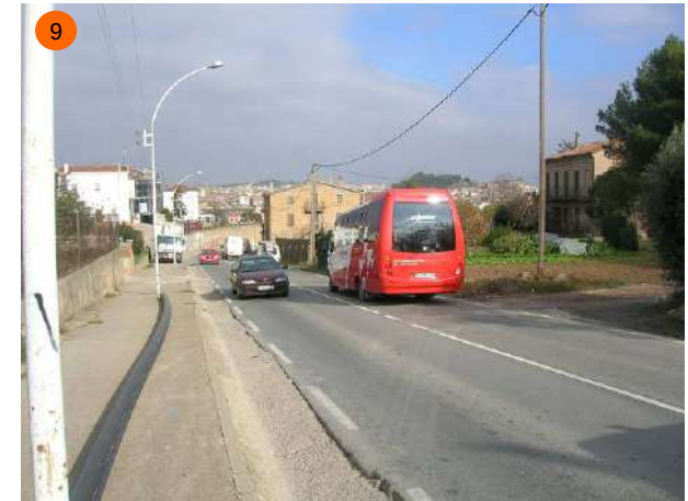
Carretera d'Igualada, pujada des del pont Sant Francesc. El pendent se suavitza i desapareixen les corbes. L'amplada dels carrils és justament la necessària per al pas de vehicles pesants.
