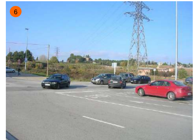
Carrer Santa Joaquina, intersecció amb l'enllaç que connecta amb la ronda Nord. En tres dels quatre brancs de la intersecció no hi ha passos de vianants.
