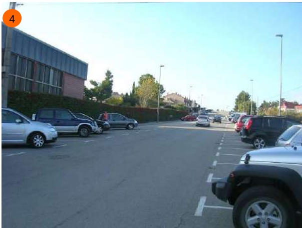
Carrer Santa Joaquina, al nord del carrer Pau. A la dreta hi ha aparcament en semibateria inversa amb bona visibilitat a l'hora de sortir. A l'esquerra hi ha aparcament en bateria sense aquesta visibilitat. El carril de circulació és molt ampli i incita a velocitats excessives.
