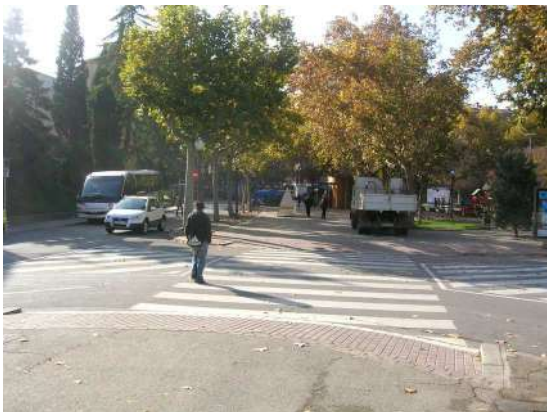
Imatge 12. Passeig Pere III, plaça d'Espanya. Un ampli espai mort allarga innecessàriament el pas de vianants i incita a maniobres irregulars.
