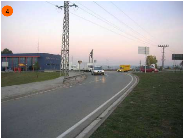
Carrer d'Alvar Aalto. El carril de sortida de la rotonda s'uneix amb el carril drecera que ve des de l'avinguda Països Catalans. També aquí el disseny permet velocitats excessives tenint en compte la perillositat de l'enllaç entre els dos carrils.
