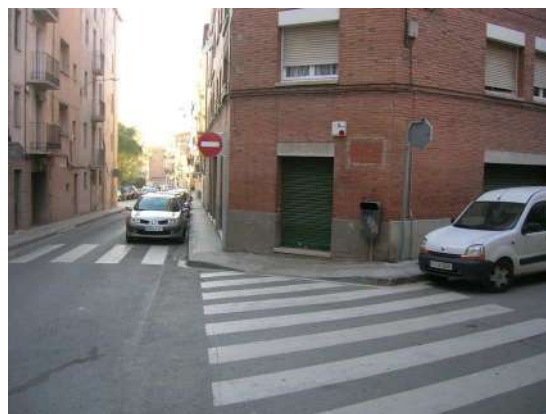
Imatge 7. Carrer Nou de Santa Clara, intersecció amb carrer Purgatori. Exemple de passos de vianants sense senyalització vertical. També manquen orelles i, a un dels passos, guals.
