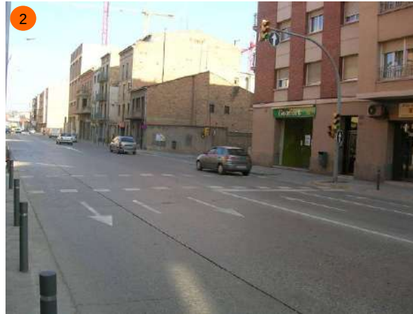
Carretera de Vic, intersecció amb el carrer Sant Cristòfol. També aquí hi ha dos carrils de gir per a tornar cap al carrer Indústria i per a accedir a la benzinera. El trànsit és intens i només una filera de pilones separa els vianants dels vehicles.
