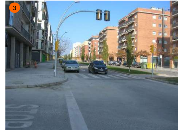
Avinguda Dolors, al nord del carrer Lluís Millet. No s'han instal·lat orelles als passos de vianants per a impedir que els cotxes aparcats perjudiquin la visibilitat entre vianants i conductors.
