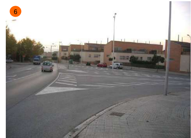
Carrer Mercè Rodoreda, intersecció amb el carrer d'Alvar Aalto. La desembocadura és excessivament àmplia i obliga els vianants a fer un encreuament molt llarg o desviar-se cap a un pas de vianants molt allunyat de la intersecció.
