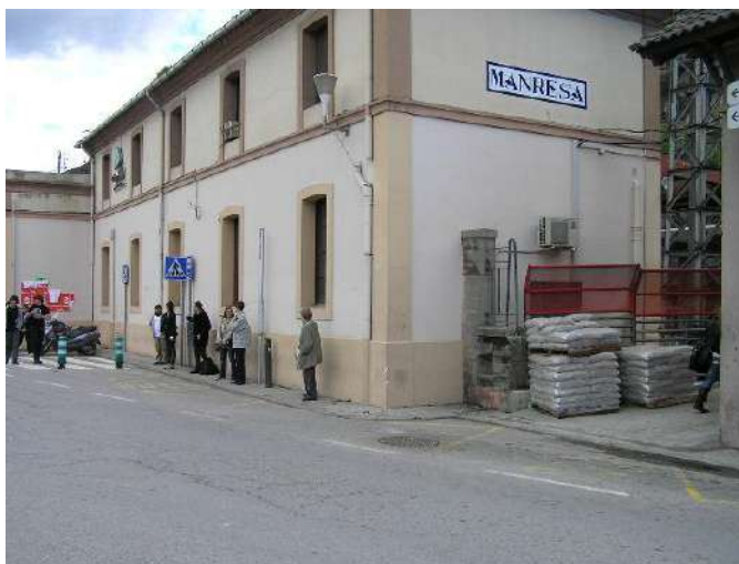
Figura 32 Parada de bus estació de RENFE
