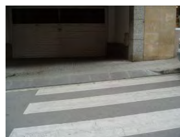
Detall gual de vehicles tipus 20/40/60 mal ubicat
