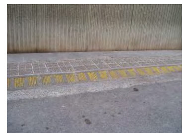
Gual de vorada deprimida en vorera d'amplada insuficient
