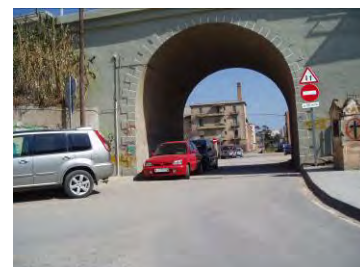
Detall pendent baix en un pas subterrani
