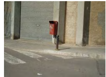
Fitó mal dissenyat i paperera mal ubicada
