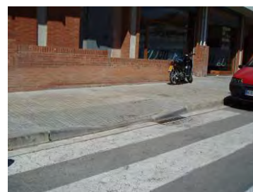
Gual tipus barca que permet l'ample de pas mínim però sense paviment d'invidents
