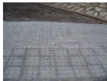
Detall paviment prefabricat 20x20 cm
