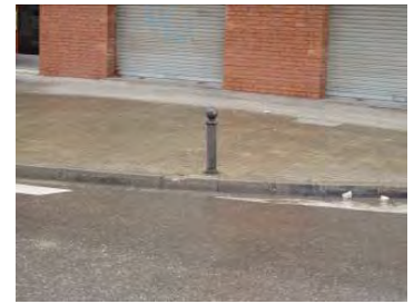
Detall fitó d'alçada inferior a 0'80 cm
