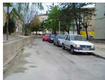
Detall de carrer amb inexistència de vorera
