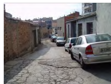
Detall plataforma única amb paviment deteriorat
