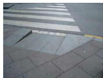
Detall gual tipus 120 sense paviment diferenciat
