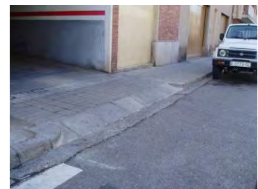
Gual tipus 40/60 que permet l'ample de pas mínim.
