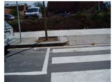
Detall escocell sense cobrir
