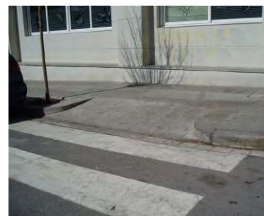
Gual tipus 120 sense paviment d'invidents
