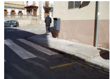
Gual tipus barca que no permet l'ample de pas d'1,20
