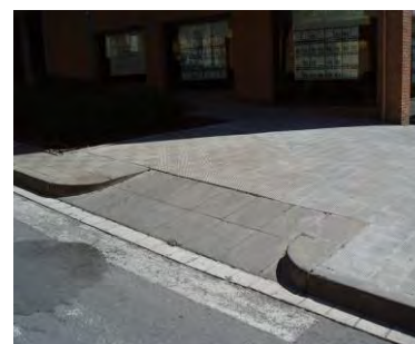
Gual tipus 120 sense paviment d'invidents
