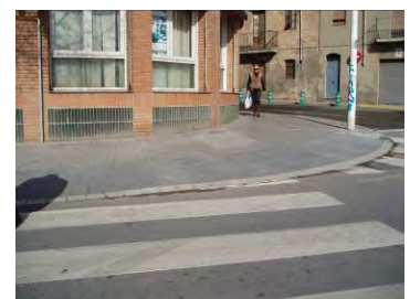
Gual en cantonada amb paviment per a invidents
