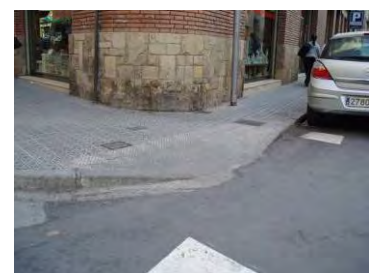
Gual tipus barca mal dissenyat i sense paviment d'invidents
