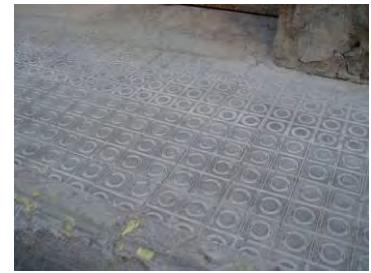
Detall del tipus de paviment
