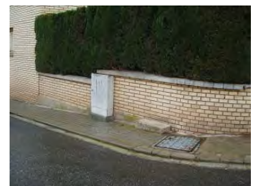
Detall armari d'instal·lacions mal ubicat
