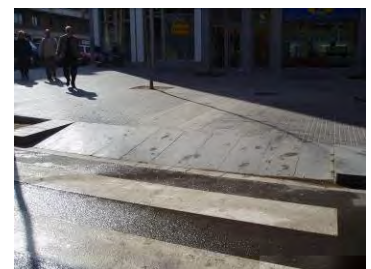
Gual tipus 120 amb paviment per a invidents
