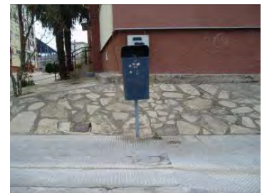
Detall paperera mal dissenyada i mal ubicada
