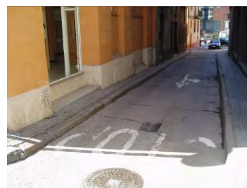
Amplada de vorera inferior a 0,90
