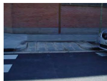
Gual tipus 120 sense franja de paviment diferenciat
