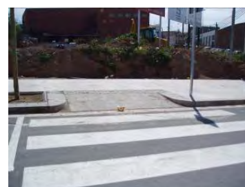
Gual tipus 120 sense franja de paviment diferenciat
