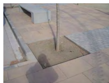
Detall escocell sense cobrir
