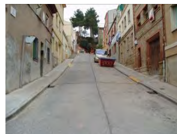
Detall pendent elevat
