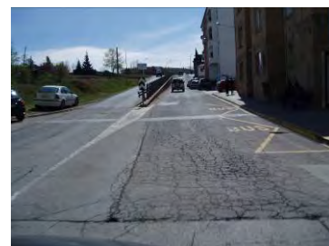
Detall pendent alt a carretera d'accés al barri
