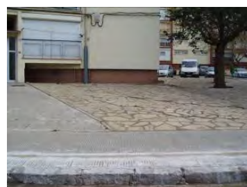
Detall paviment peces depedra pulida
