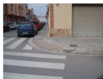
Detall gual amb paviment diferenciat mal dissenyat
