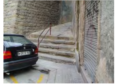
Detall escales mal dissenyades
