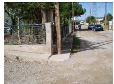
Detall pla d'instal·lacions mal ubicat
