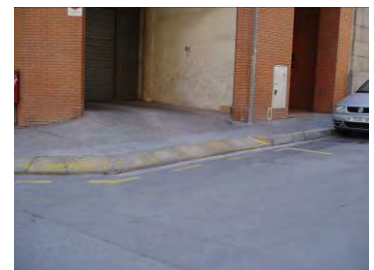
Gual tipus 40/60 mal ubicat ja que es troba al lloc d'un gual de vianants.
