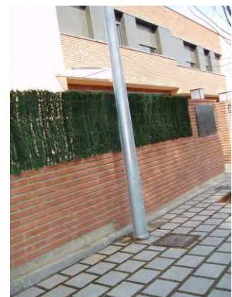
Detall bàcul mal ubicat (Bellavista)
