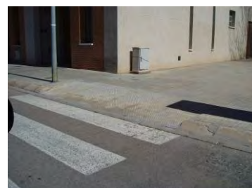
Gual de fabricació pròpia imitant un gual tipus 120.
