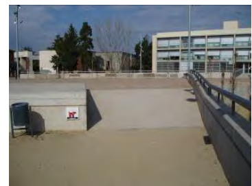
Detall rampa sense passamans
