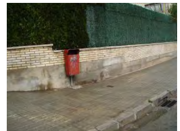
Detall paperera mal dissenyada i mal ubicada
