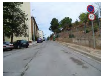
Detall de carrer amb inexistència de vorera
