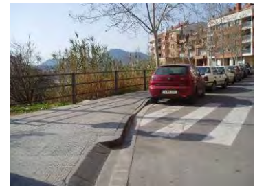
Gual tipus barca mal ressalt i sense paviment d'invidents
