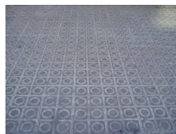
Detall paviment prefabricat 20x20cm
