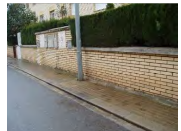
Detall bàcul mal ubicat
