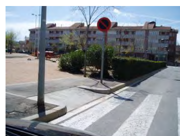
Gual tipus 120 sense paviment d'invidents
