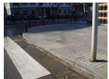
Gual tipus barca sense paviment per a invidents
