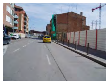
Detall pendent baix a la carretera de Vic
