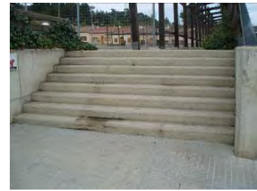
Detall escales sense passamans (Comptals)
