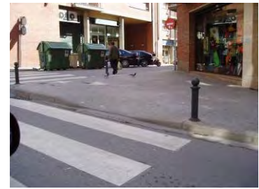
Gual tipus barca sense paviment d'invidents
