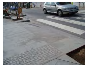
Detall gual tipus 120 sense paviment diferenciat
