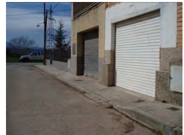
Detall gual de vehicles tipus barca mal dissenyat (Sol i Aire)
