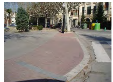
Gual tipus 120 de fabricació pròpia
