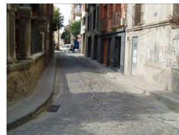
Detall Voreres inferiors a 0'90m
