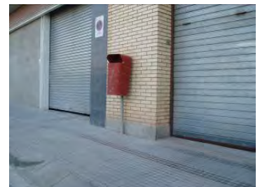
Detall paperera mal dissenyada i mal ubicada
