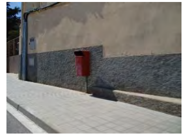
Detall paperera mal dissenyada i mal ubicada
