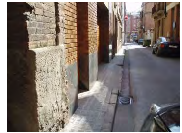
Gual tipus 120 ubicat en vorera d'amplada insuficient
