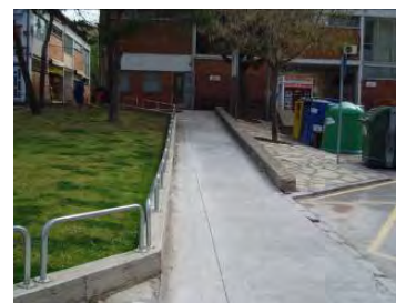
Detall rampa sense baranes ni passamans
