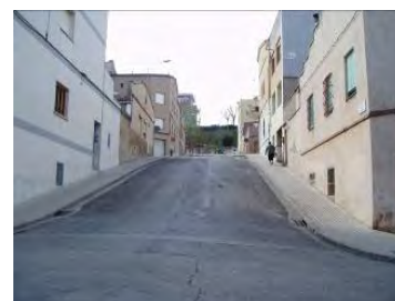
Detall pendent elevat
