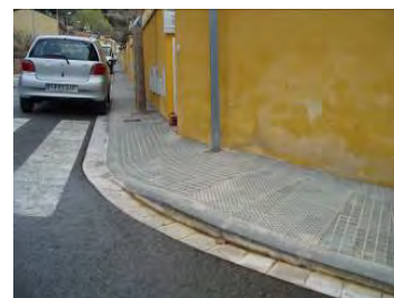
Detall gual tipus vorera deprimida mal dissenyat
