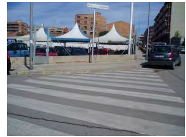
Inexistència de gual de vianant en una cruïlla
