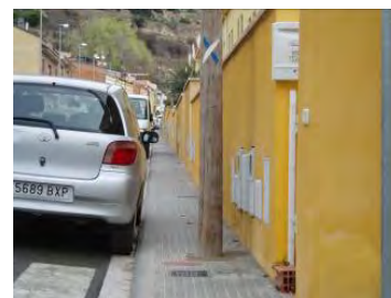
Detall pal d'instal·lacions mal ubicat
