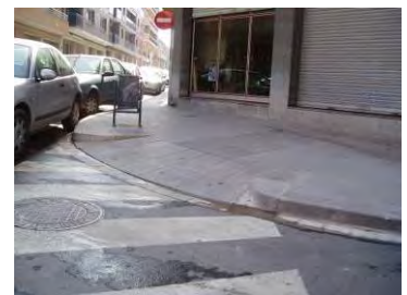
Gual tipus 120 mal dissenyat amb paviment d'invidents
