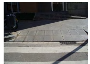
Gual tipus 120 sense paviment d'invidents
