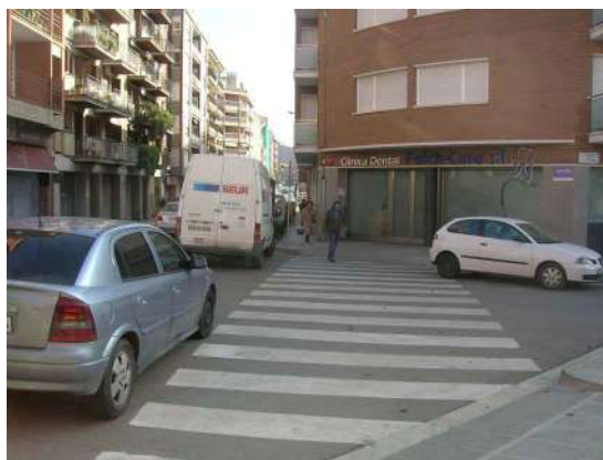
Imatge 8. Avinguda Tudela, intersecció passatge Can Saltes. L'absència d'orelles implica un pas de vianants molt llarg i una visibilitat nefasta per causa dels vehicles aparcats als xamfrans.
