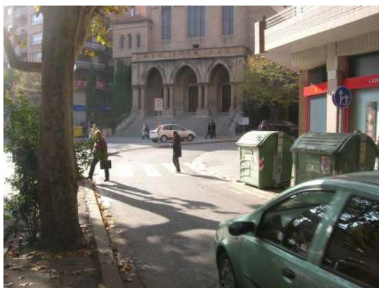
Imatge 7. Passeig Pere III, intersecció amb carrer d'Angel. Contenidors de brossa perjudiquen la visibilitat al pas de vianants.
