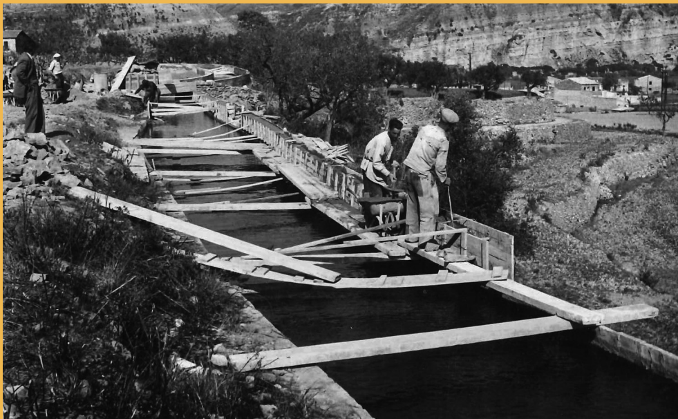
La brigada muntant murs de formigó a la Sèquia (Centre de Documentació i Arxiu Històric Can Font)
