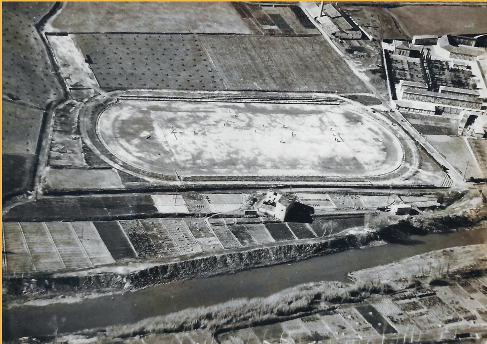
Fotografia de la construcció de l'estadi d'atletisme del Congost, l'any 1951 (Arxiu Josep Pla March)
