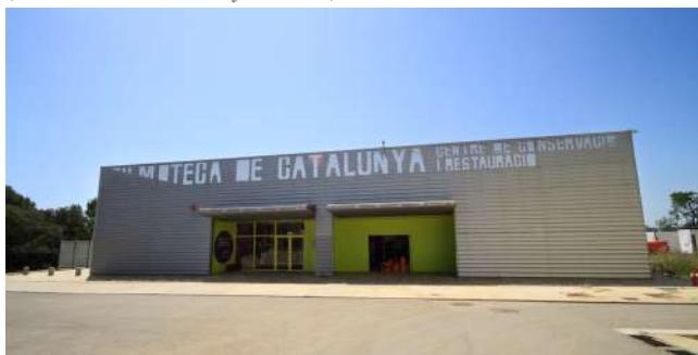
Façana del Centre de Restauració i Conservació de la Filmoteca de Catalunya, 2CR. (Filmoteca de Catalunya - ICEC)
