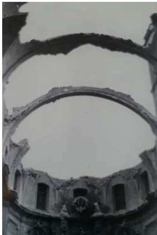
Fig. 75 Sostre a mig enderroc de l'església. a sota dels arcs de volta es poden observar elements decoratius de l'altar major, que fou acabat el 1740.
