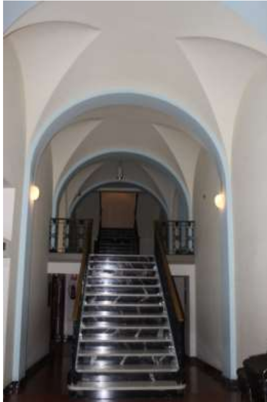
Fig. 56 Fotografia del passadís rere el vestíbul on es poden veure les voles neoclàssiques del claustre i les escales que porten a l'entresòl. Fotografia de l'autora.
