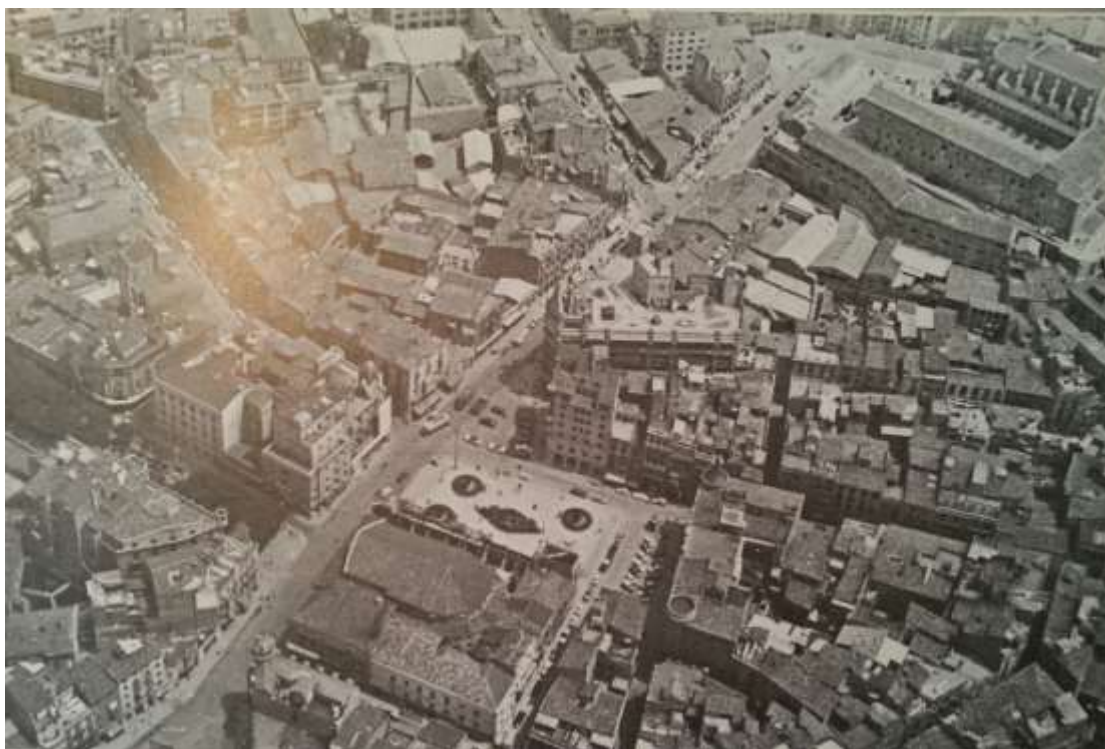
Fig. 4 Vista aèria del centre on es pot veure la plaça Sant Domènec i l'estructura del Teatre Conservatori, GASOL, 1984, p. 21
