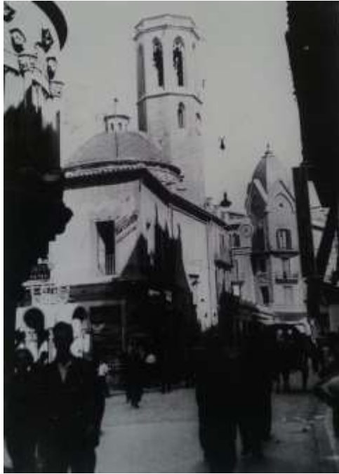
Fig. 72 L'església de Sant Pere Màrtir, situada a la plaça Sant Domènec, setembre del 1936, pocs dies abans que s'iniciés l'enderroc. A primer pla, l'edifici adossat a la parròquia, que estatjava la sastreria Fornells i la Joieria Busquets. ALOY, 1992 – 1993, V. I, p. 172
