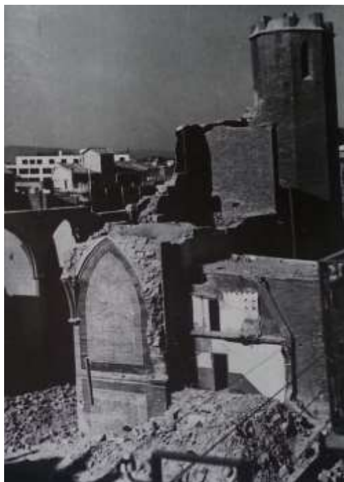
Fig. 81 Instantànies de la demolició de l'església de Sant Pere Màrtir al llarg del mes de novembre de 1936. ALOY, 1992 – 1993, V. I, p. 179
