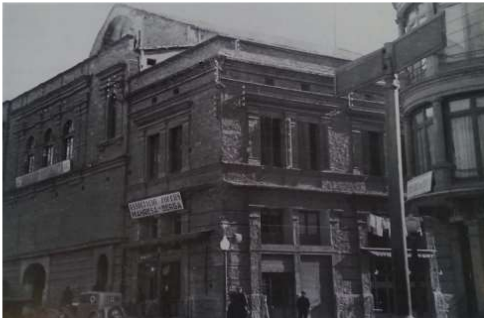
Fig. 73 L'edifici del Teatre Conservatori i edificis del carrer Jaume I, novembre el 1936, poc després de que s'acordés l'enderrocament de tota l'illa d'edificacions de la plaça de Sant Domènec. ALOY, 1992 – 1993, V. I, p. 192
