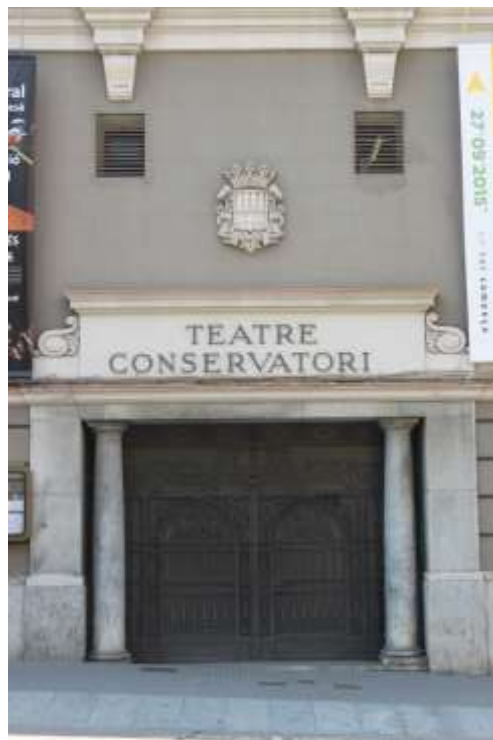
Fig. 53 Detall de la porta principal de la façana que es troba a la Carretera Cardona en front del Passeig Pere III. Fotografia de l'autora.
