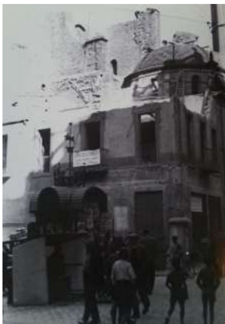
Fig. 78 Setembre – octubre de 1936, l'enderroc ha començat. El sostre de l'edifici annex ja està esbucacat. Uns llenços penjats a la sastreria Fornells i a la Joieria Busquets informen del trasllat d'aquests dos comerços. A dalt, els obrers treballen l'enderroc. ALOY, 1992 – 1993, V. I, p. 172
