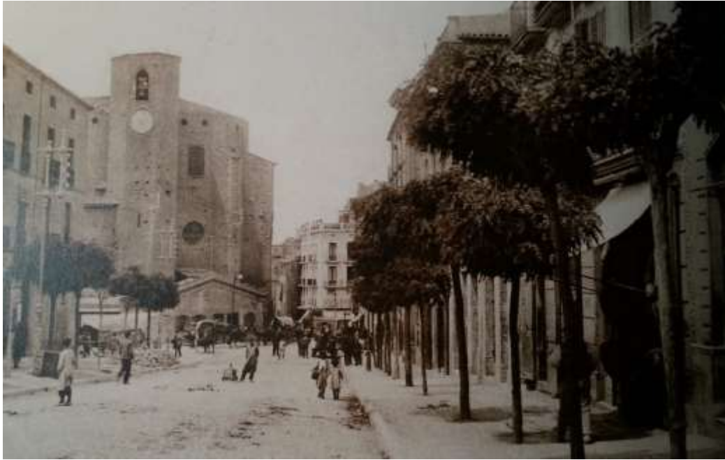
Fig. 70 La muralla del Carme amb la primitiva església de Sant Pere Màrtir al fons i la carretera envaïda per carros i vianants, en una imatge de principis del segle XX. GARCIA, 2002, p. 544
