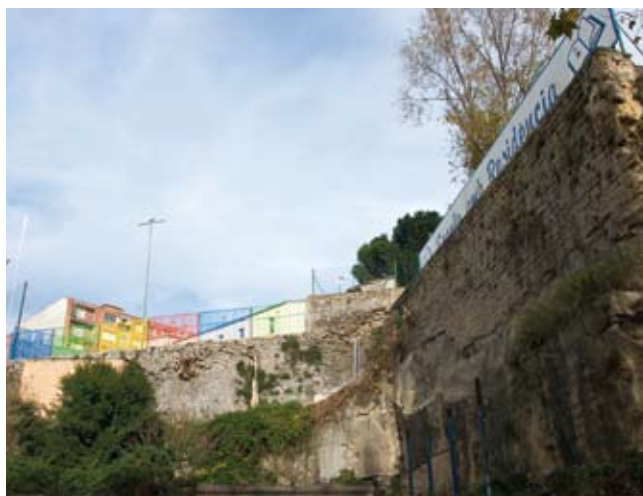
↑ Tram de muralla del sector occidental de la ciutat (David Grau)
