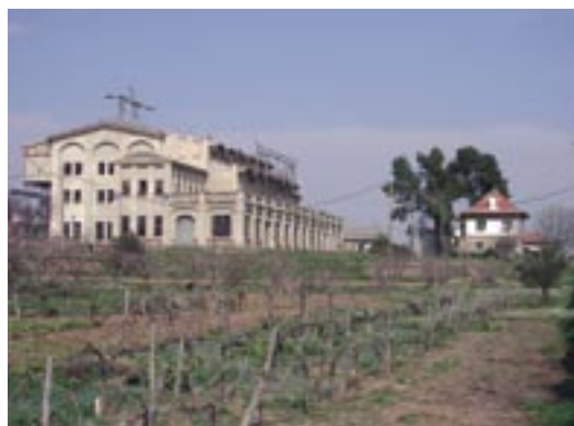
Central de Fecsa, la Catalana
