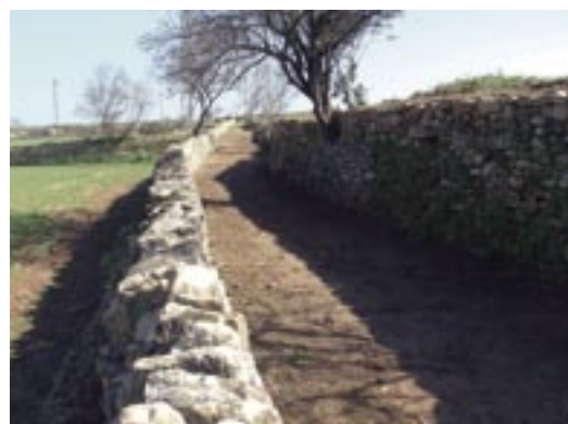
Murs de pedra seca recuperats a un camí ral
