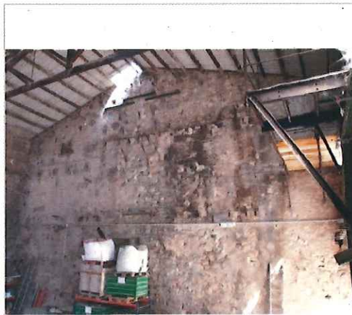
Mur central de paredat
