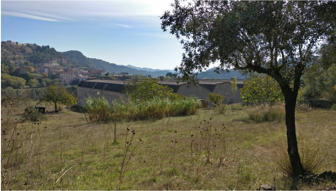
VISTA DE LA NAU DES DE EL NORD DE LA PARCEL·LA I VISIÓ EN DIRECCIÓ AL SUD.
