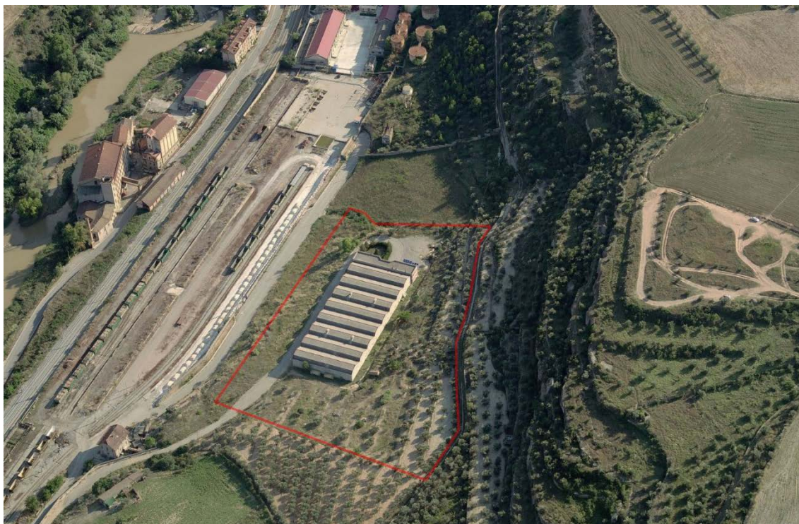
VISTA AÈRIA DES DE EL NORD
