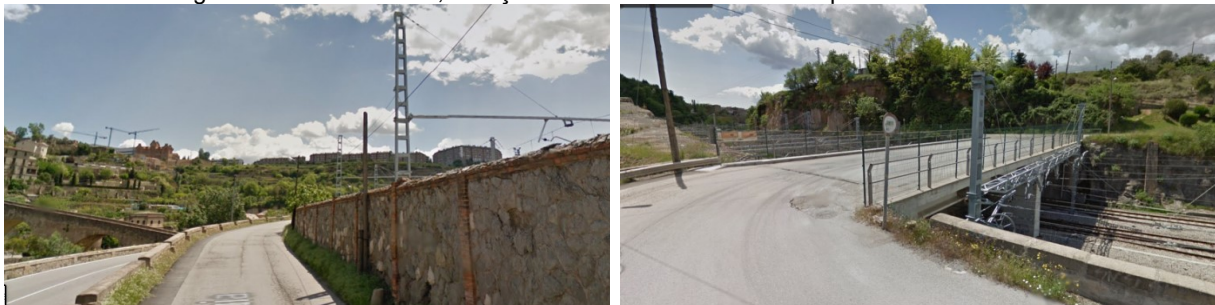
Imatge 4. Carrer de la Guia, a l'alçada de la carretera C-1411b i pont sobre vies del tren
