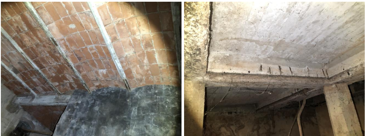
221004132 i 221004137. Aspecte dels sostres de l'espai semisoterrat de la boca de les turbines.
