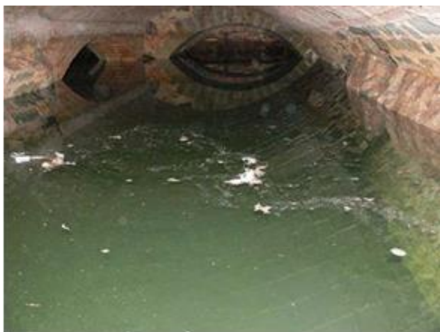
150 i 151. Vista de les galeries soterrades de desguàs de la sala de turbines, que creuen la nau. Font: Piqué i Escalè, 2010.
