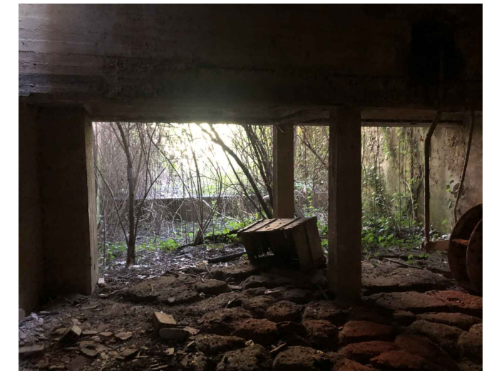
SB04: INTERIOR DEL COS ANNEX
