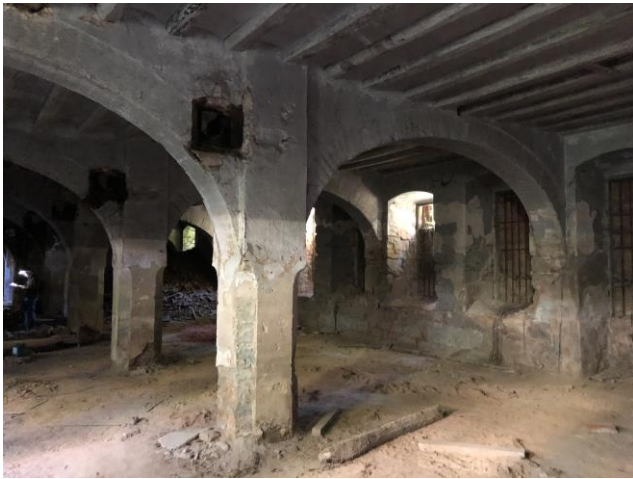
I28 i I29. Vista interior de la planta semisoterrani. Font: Elaboració pròpia.
