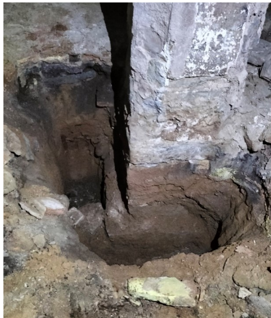
Cala de reconeixement en pilar central
