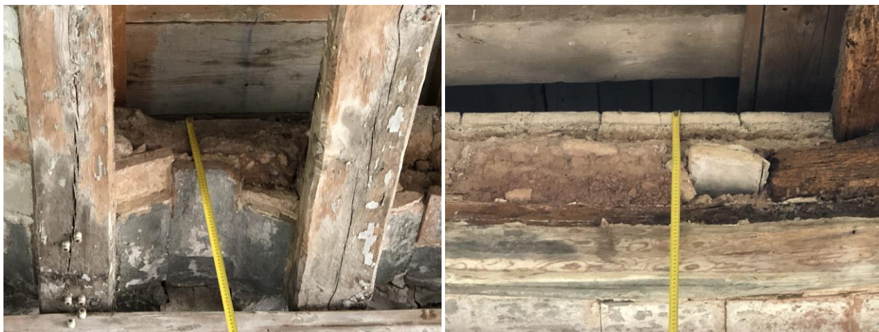
Imatges 220729113 i 220729118. Mesures de gruixos dels sostres unidireccionals a la clau del revoltó i a l'estrep damunt biga.
