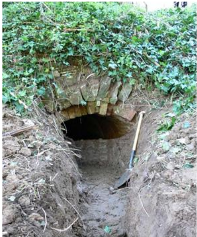
I38 i I39. Imatges de l'interior de la segona galeria de desguàs i de la boca de sortida al riu. Font: Piqué i Escalè, 2010.
