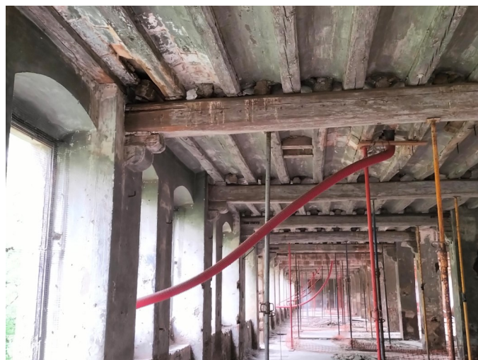
Vista del mur de façana, apilastrat
