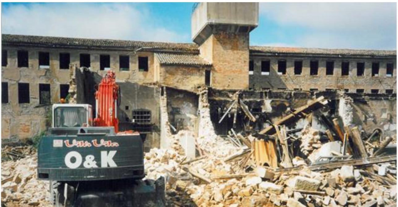
Imatge 11. Treballs d'enderroc de les naus auxiliars existents en el recinte. Setembre 1999. Font: Piqué-Escalé, 2010.
