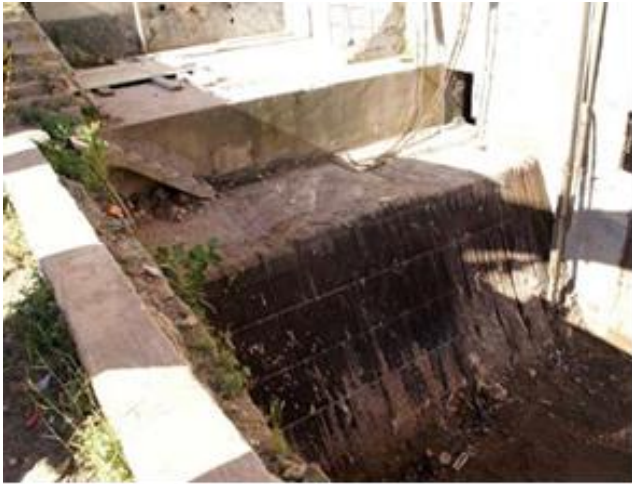
146 i 147. Aspecte de la boca d'entrada del canal al cos semisoterrat de turbines, annex a la nau principal. En aquell moment hi havia un reixat metàl·lic, actualment desaparegut per un robatori recent. Font: Piqué i Escalè, 2010.
