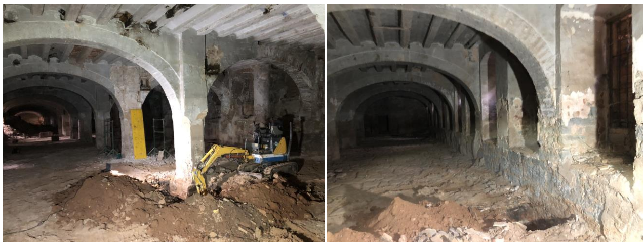
Imatges 22111527 i 22111528. Situació de les cales de fonamentació realitzades.
