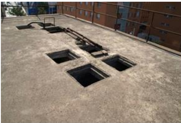
160 i 161. Estat de la coberta plana del dipòsit, amb recollida d'aigües cap als extrems, i gàrgoles exteriors de zinc. A la coberta hi ha set obertures, sis d'elles donen accés a les diferents unitats en que interiorment es subdivideix, la setena hi ha ubicada una escala de gat i és per a on s'accedeix per a fer tasques de manteniment. Per aquests darrer forat també pujaven tubs que conduïen aigua. Font: Piqué i Escalè, 2010.
