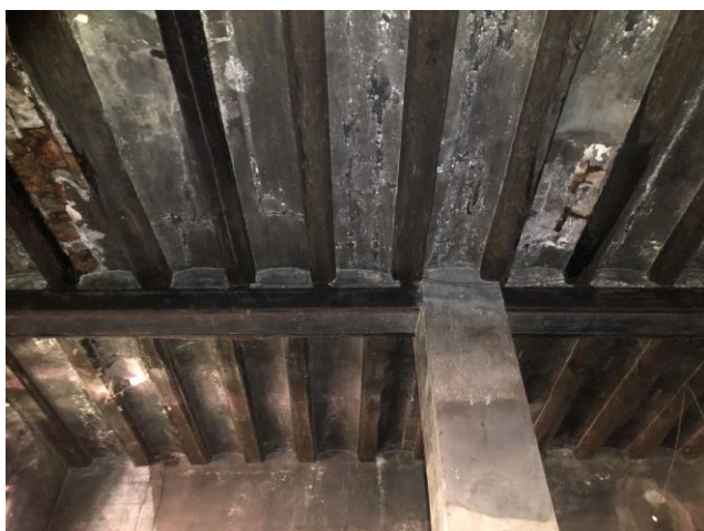
221004101 i 221004174. Exemples d'elements estructurals de ferro afectats per oxidació de ferro.
