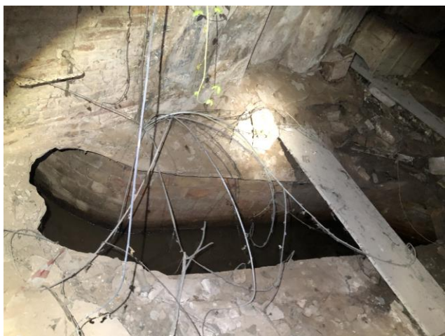
221004158 i 221004161. Exemples d'esfondraments de trams de voltes de maó de pla de galeries soterrades que creuen la nau.
