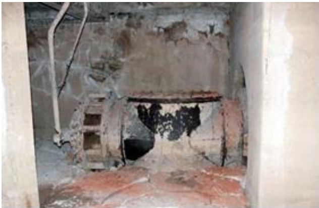
148 i 149. Estat de l'interior del cos semisoterrat de turbines, annex a la nau principal. Les turbines que poden observar a les imatges inferiors, són les que s'hi van instal·lar a principis dels anys 40, són dues turbines del tipus Francis, d'eix horitzontal, amb dos rodets cadascuna. Font: Piqué i Escalè, 2010.
