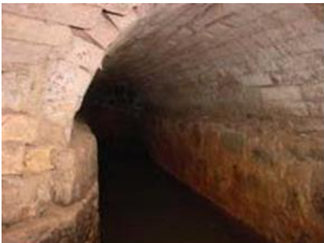
I44 i I45. Imatges de l'interior de la tercera galeria de desguàs i de la zona aproximada de la boca de sortida al riu colgada de terres.. Font: Piqué i Escalè, 2010.
