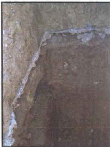
Detall dels materials de rebliment a partir d'una cala efectuada per a l'emplaçament d'una grúa.
