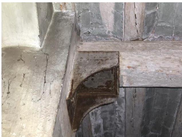
22100439 i 22011240. Exemples d'elements estructurals de ferro afectats per oxidació aparentment superficial.
