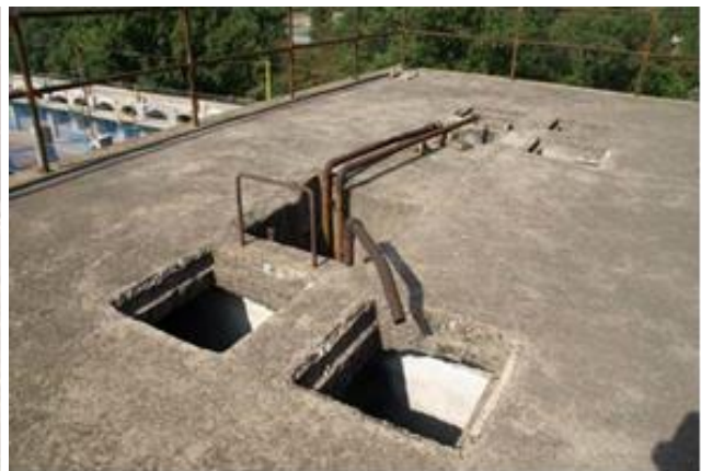
160 i 161. Estat de la coberta plana del dipòsit, amb recollida d'aigües cap als extrems, i gàrgoles exteriors de zinc. A la coberta hi ha set obertures, sis d'elles donen accés a les diferents unitats en que interiorment es subdivideix, la setena hi ha ubicada una escala de gat i és per a on s'accedeix per a fer tasques de manteniment. Per aquests darrer forat també pujaven tubs que conduïen aigua. Font: Piqué i Escalè, 2010.
