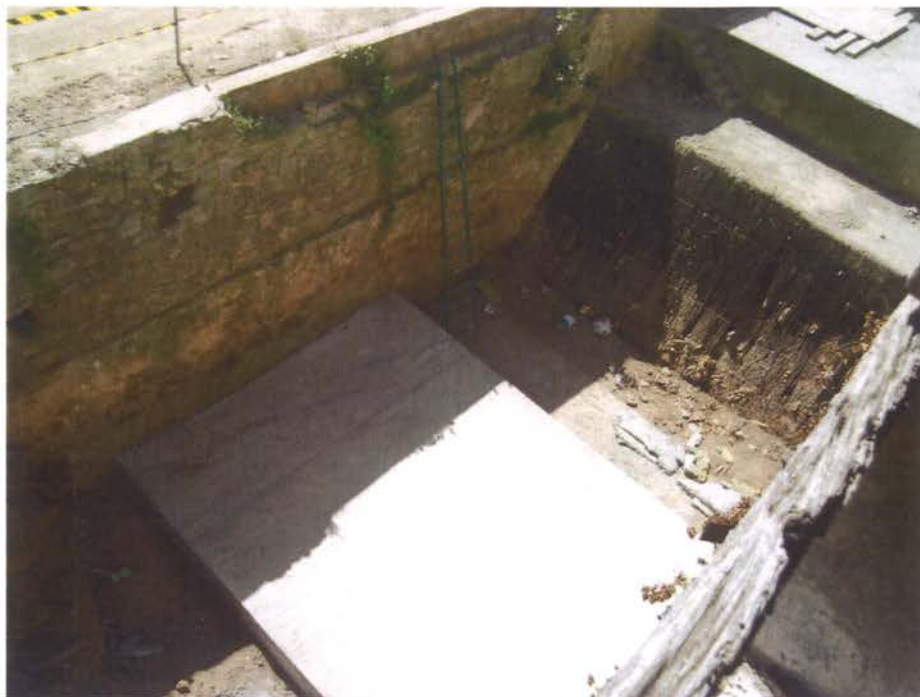
Imatge del dau de formigó que actuarà com a fonament de la grua, ja realitzat.
