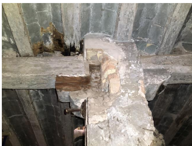
126 i 127. Detall de sostre i mènsula de la planta baixa amb cala prèviament realitzada per identificar composició material de la secció constructiva. Font: Elaboració pròpia.
