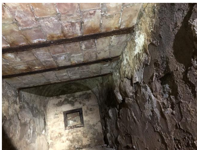
221004101 i 221004174. Exemples d'elements estructurals de ferro afectats per oxidació de ferro.
