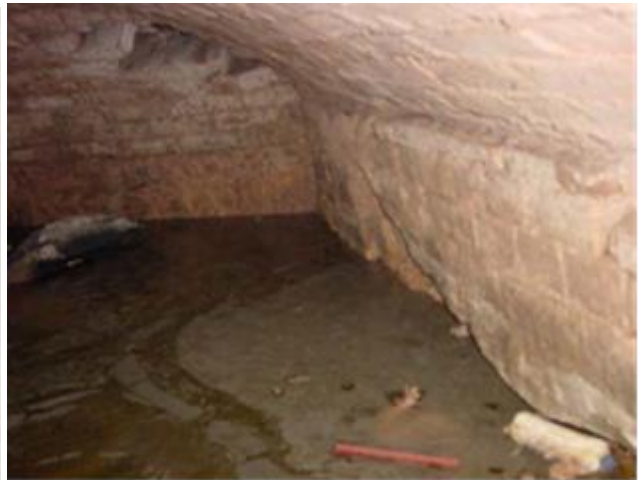
I40 i I41. Estat de la comporta de regulació de la tercera galeria soterrada de desguàs que travessa la nau i d'un esfondrament interior de la galeria. Font: Piqué i Escalè, 2010.
