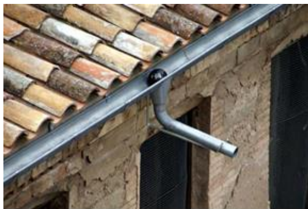
166 i 167. Detalls de les capes de les vessants de la coberta i del canaló i gàrgoles perimetrals de les obres del 2009. Font: Piqué i Escalè, 2010.
