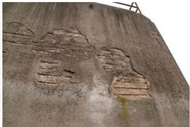
162 i 163. Detall d'una cantonada de la coberta del dipòsit i d'un tram de parament vertical amb armat oxidat. Font: Piqué i Escalè, 2010.
