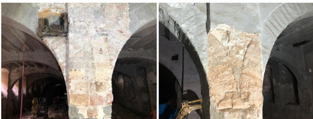
Imatges 22111544 i 22111502. Realització de cales per esbrinar composició constructiva del tronc superior dels pilars centrals del semisoterrani.
