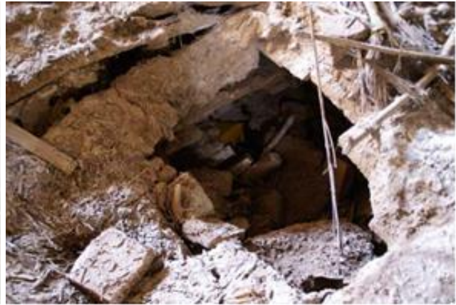
I36 i I37. Estat de la comporta de regulació de la segona galeria soterrada de desguàs que travessa la nau i d'un esfondrament interior de la galeria. Font: Piqué i Escalè, 2010.
