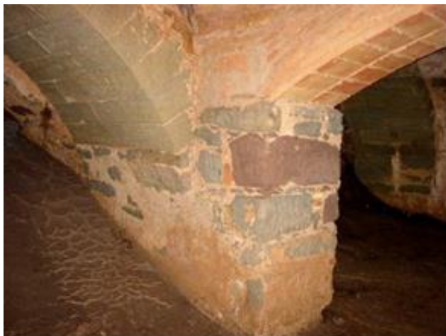
I52 i I53. Estat de les galeries soterrades de desguàs de la sala de turbines, que creuen la nau. Font: Piqué i Escalè, 2010.
