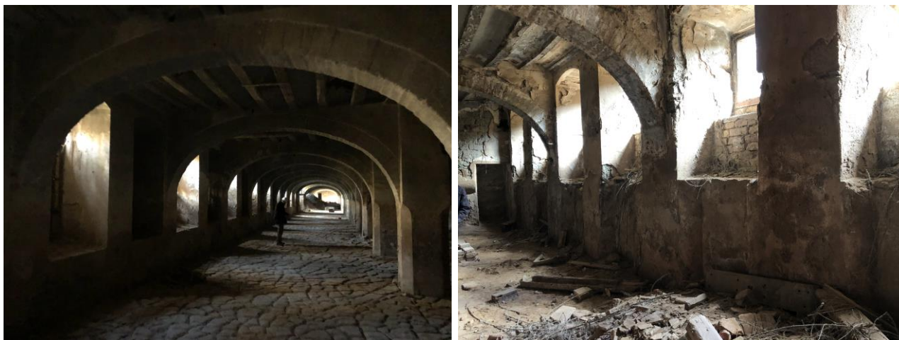
22011254 i 22011226. Exemples de la presència de runes i rebleres de llots al nivell del semisoterrani.
