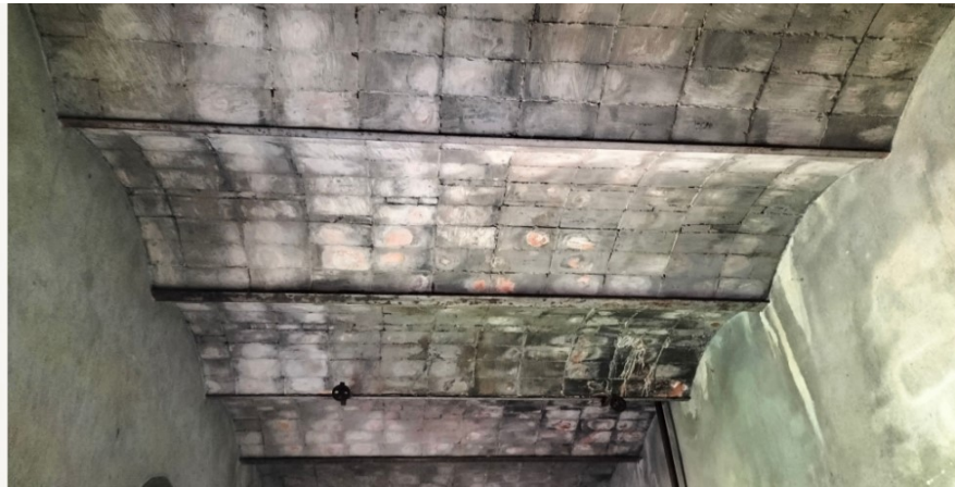
Forjats de bigueta metàl·lica, a la torre
