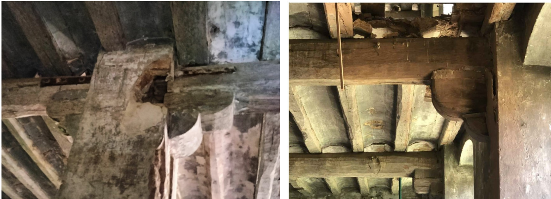
Imatge del recolzament de les bigues, per mitjà de 'dobles' mènsules
