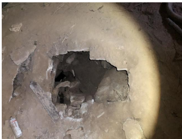
221004158 i 221004161. Exemples d'esfondraments de trams de voltes de maó de pla de galeries soterrades que creuen la nau.
