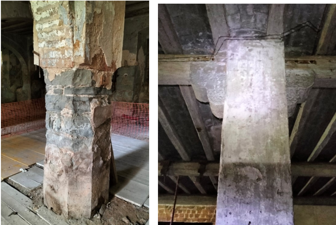
Aspecte dels pilars centrals en planta soterrani i baixa
