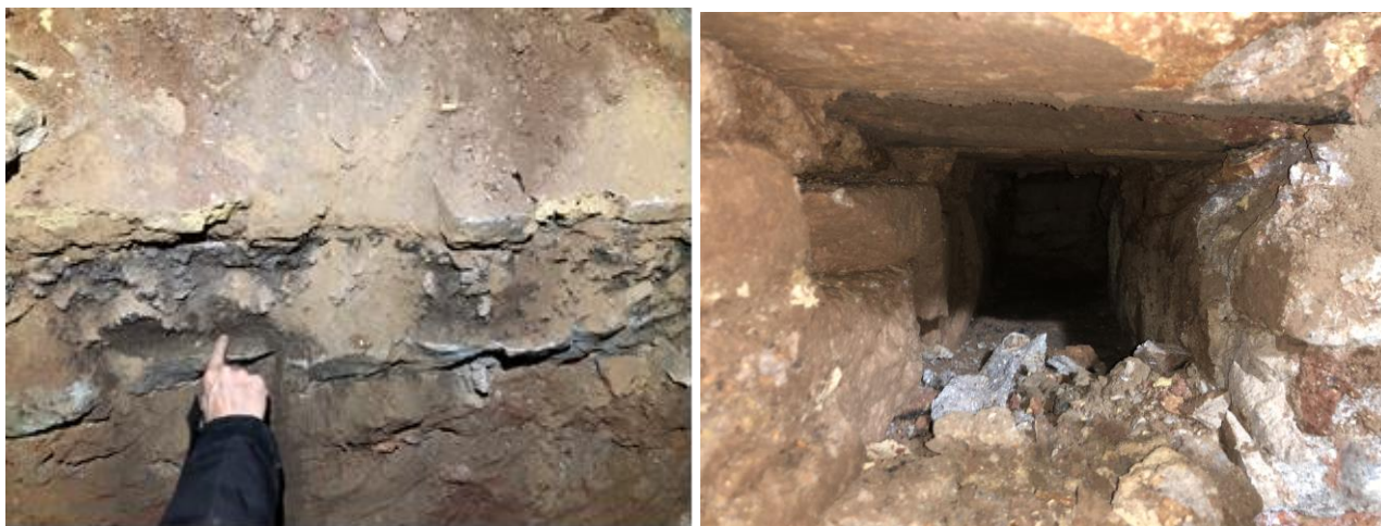
Imatges 22111632 i 22111511. Nivells de paviments sobreposats al semisoterrani, i vista d'una de les canals soterrades arran de pilars centrals.
