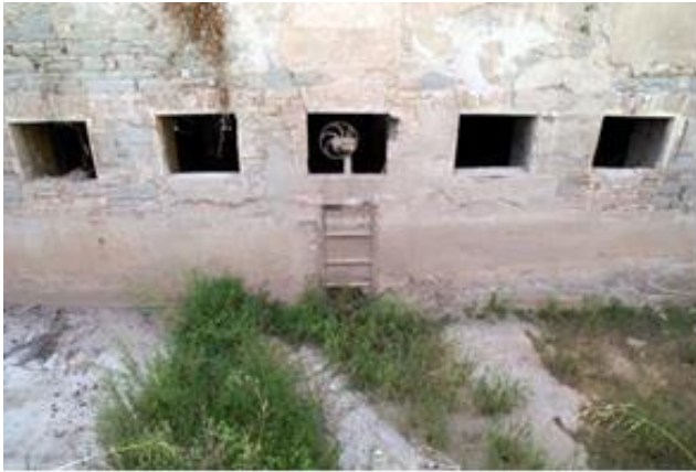
I36 i I37. Estat de la comporta de regulació de la segona galeria soterrada de desguàs que travessa la nau i d'un esfondrament interior de la galeria. Font: Piqué i Escalè, 2010.
