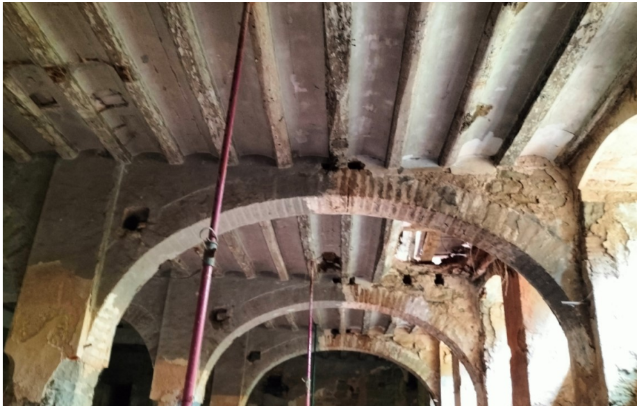
Arcs 'carpentell' en planta semisoterrani
