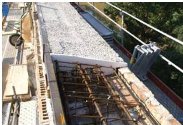
164 i 165. Secció tipus de la rehabilitació de coberta de l'any 2009, i detall del cèrcol al coronament dels murs. Font: Piqué i Escalè, 2010.
