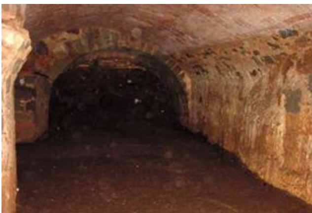
I54 i I55. Estat de les galeries soterrades de desguàs de la sala de turbines, que creuen la nau. Font: Piqué i Escalè, 2010.
