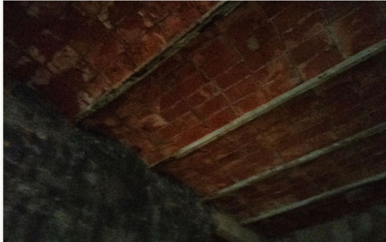
Forjats de bigueta de formigó, en el sostre de la sala de turbines
