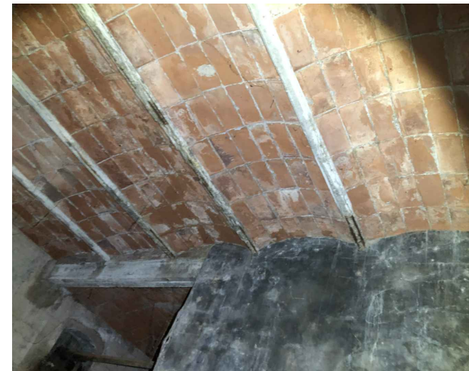
SB03: INTERIOR DEL COS ANNEX
