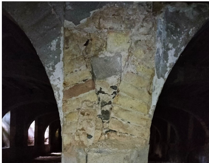
Pilastra on s'ha després l' 'engaltat' lateral , mostrant la seva composició interior.
