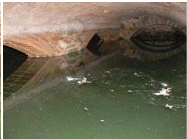
150 i 151. Vista de les galeries soterrades de desguàs de la sala de turbines, que creuen la nau. Font: Piqué i Escalè, 2010.
