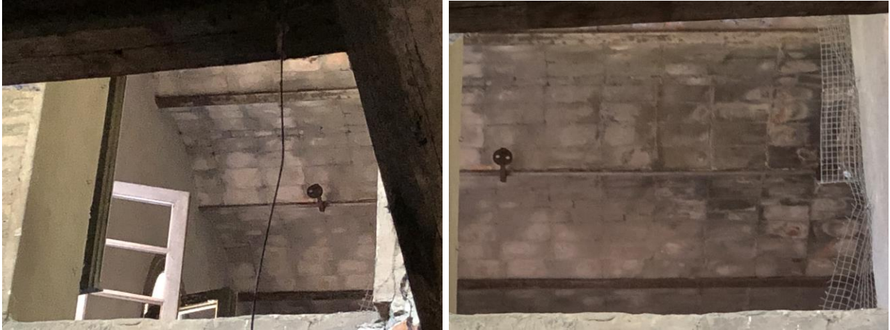
221004115 i 221004115. Imatges de trams de sostres de l'interior del volum edificat annex a la nau.
