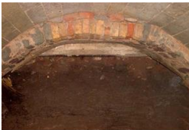
I54 i I55. Estat de les galeries soterrades de desguàs de la sala de turbines, que creuen la nau. Font: Piqué i Escalè, 2010.
