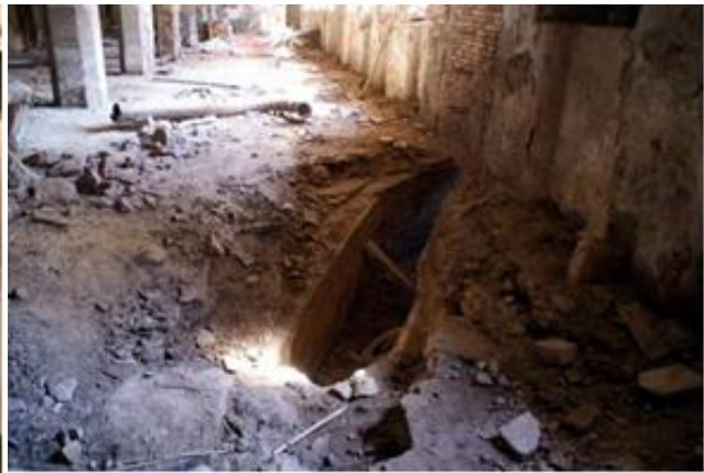
I40 i I41. Estat de la comporta de regulació de la tercera galeria soterrada de desguàs que travessa la nau i d'un esfondrament interior de la galeria. Font: Piqué i Escalè, 2010.
