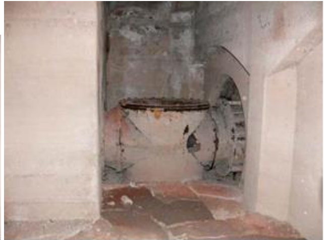
148 i 149. Estat de l'interior del cos semisoterrat de turbines, annex a la nau principal. Les turbines que poden observar a les imatges inferiors, són les que s'hi van instal·lar a principis dels anys 40, són dues turbines del tipus Francis, d'eix horitzontal, amb dos rodets cadascuna. Font: Piqué i Escalè, 2010.
