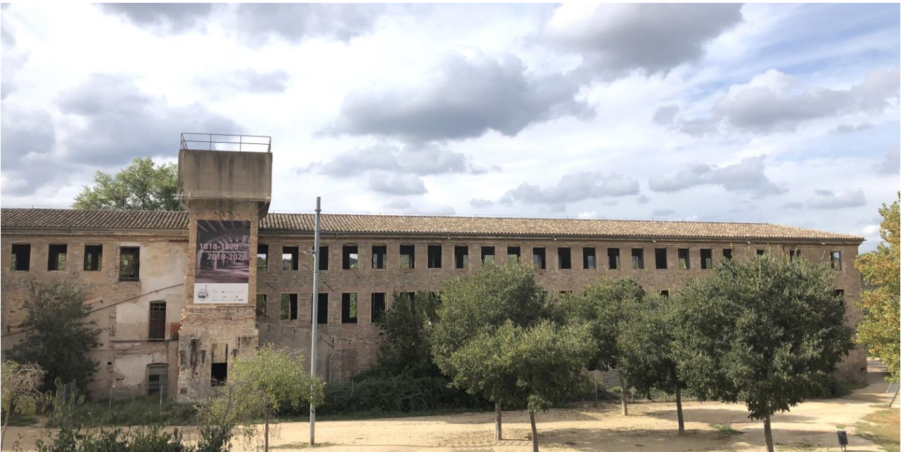
I02. Façana est. Font: Elaboració pròpia.
