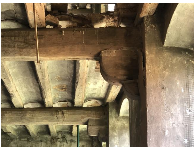
126 i 127. Detall de sostre i mènsula de la planta baixa amb cala prèviament realitzada per identificar composició material de la secció constructiva. Font: Elaboració pròpia.
