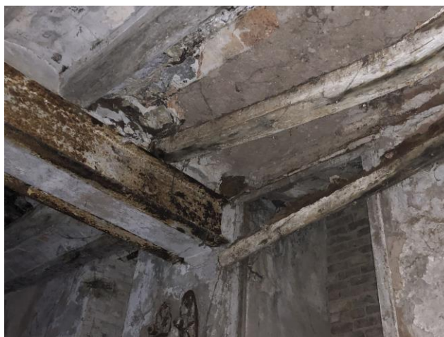
22100439 i 22011240. Exemples d'elements estructurals de ferro afectats per oxidació aparentment superficial.
