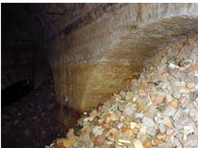
I56 i I57. Estat de la boca de desguàs de les galeries soterrades de la sala de turbines obturades de runes i colgades a l'exterior, a la vora el riu Cardener. Font: Piqué i Escalè, 2010.
