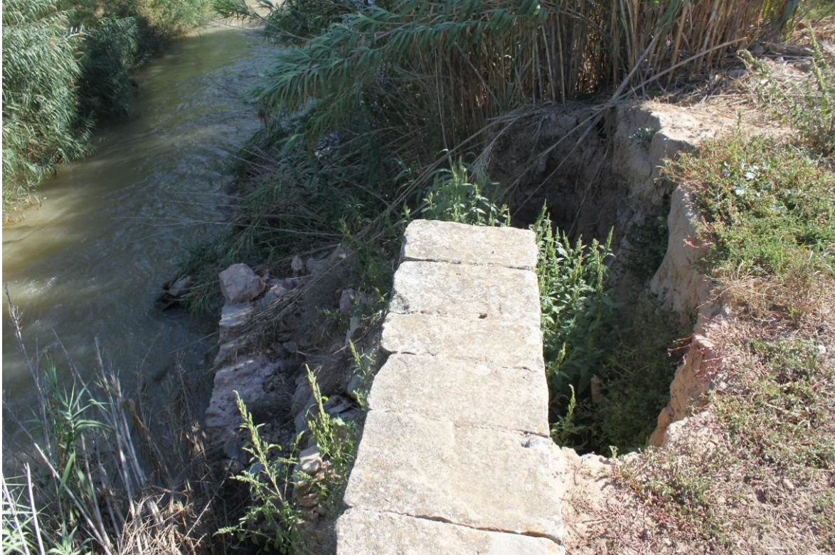
Fotografia 15. Erosió lateral del riu cardener sobre un Mur
