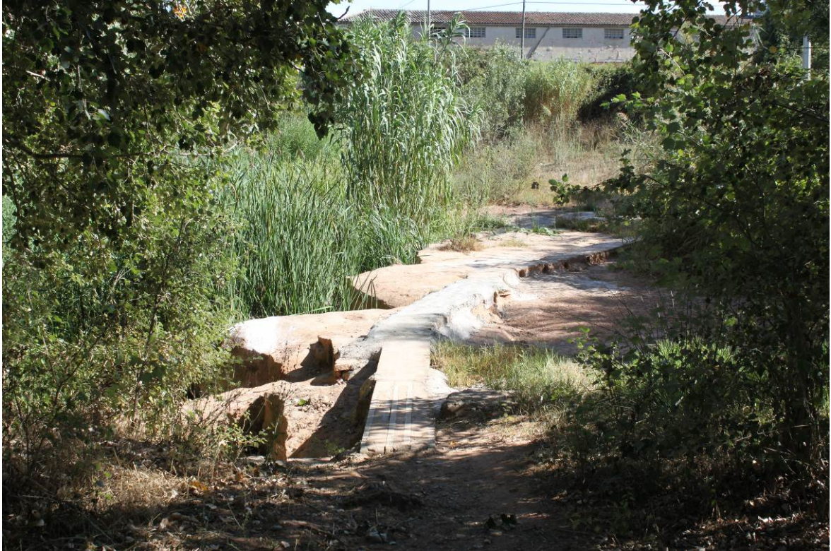
Fotografia 22. Torrent del xup
