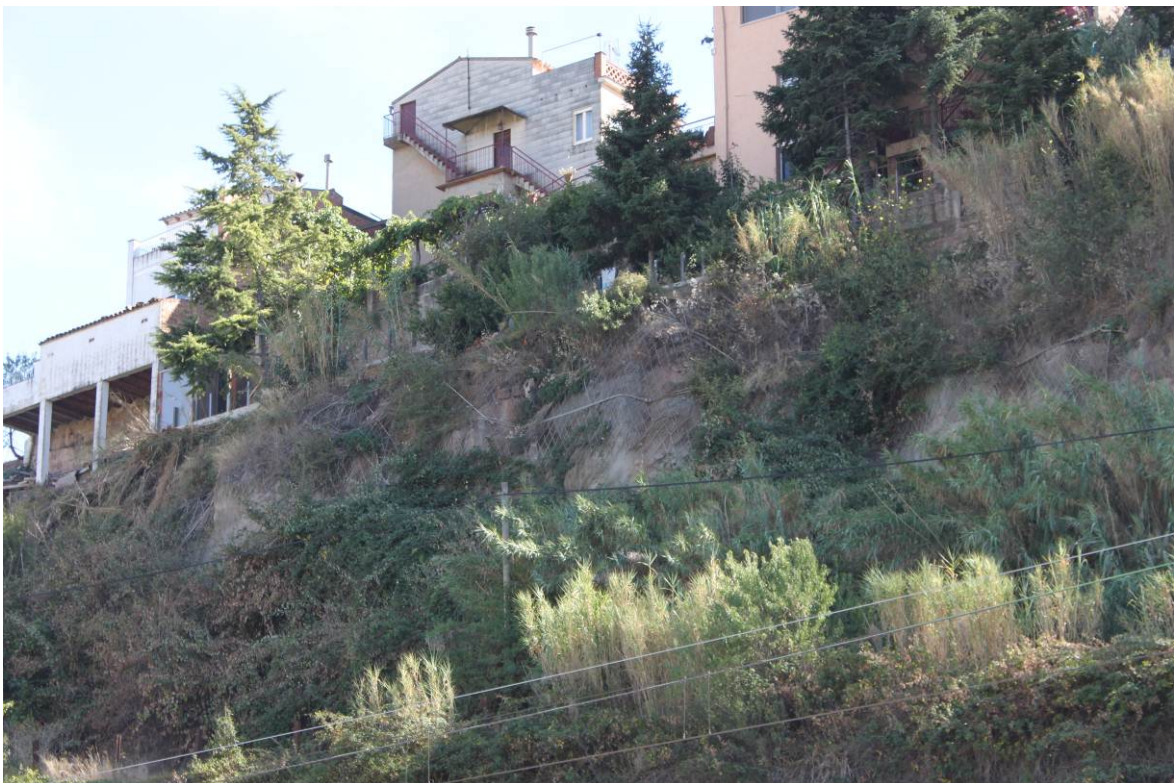
Fotografia 20. Malles de protecció i formigó projectat en el vessant nord del Nucli de les tres creus
