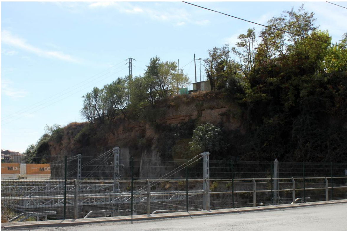
Fotografia 16. Retrocés del cap del talús en el sector la Guia
