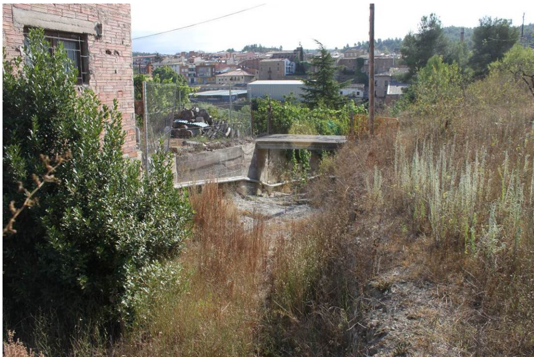
Fotografia 25. Vista del torrent que passa pel sud del raval de Manresa
