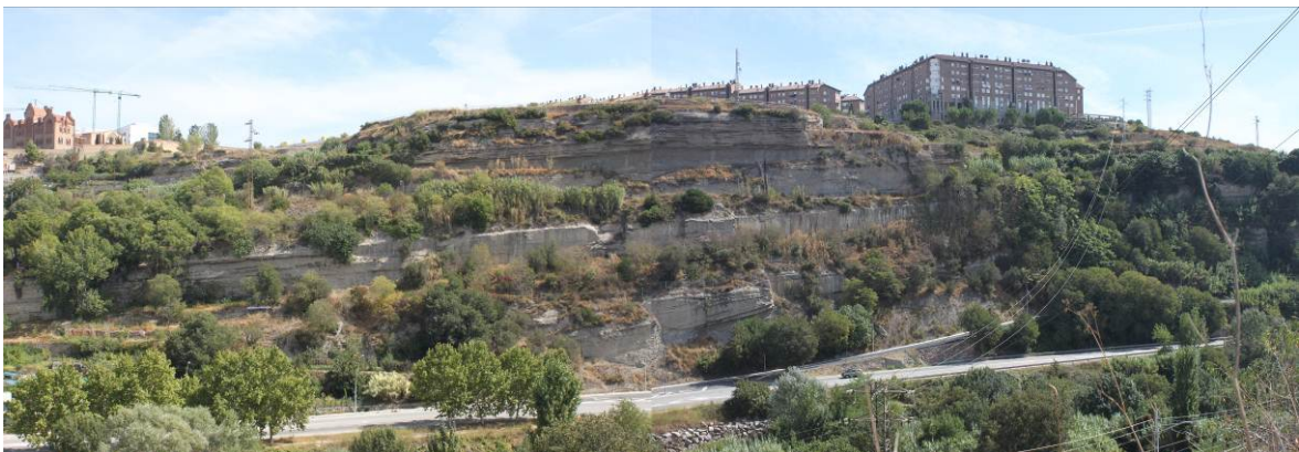
Fotografia 7. Afloraments rocosos en el traçat dels FGC
