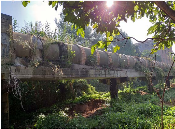
Figura 28. Col·lector d'aigües residuals que actualment les condueix a l'EDAR de Manresa
