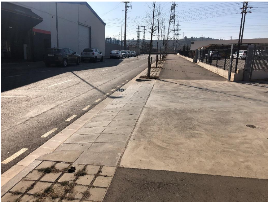
Figura 24. Gual al tram executat del carrer de la Lemmerz (àmbit AU3).
