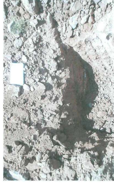
DETALLE DE LA EXCAVACIÓN DE LA CALICATA C-9.
