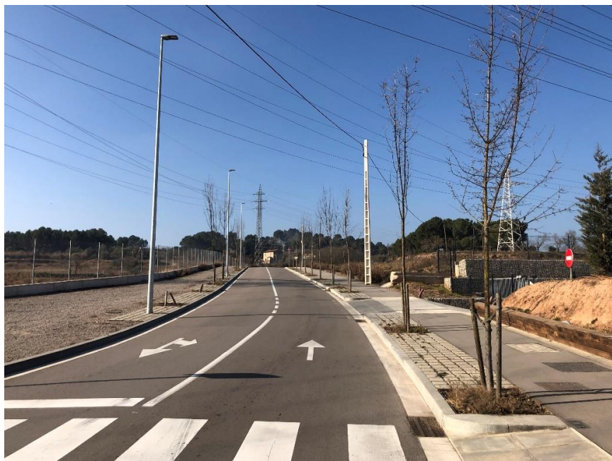
Figura 26. Tram executat del Camí del Suanya (àmbit AU3).
