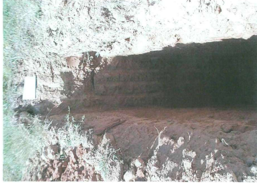
DETALLE DE LA EXCAVACIÓN DE LA CALICATA C-4.
