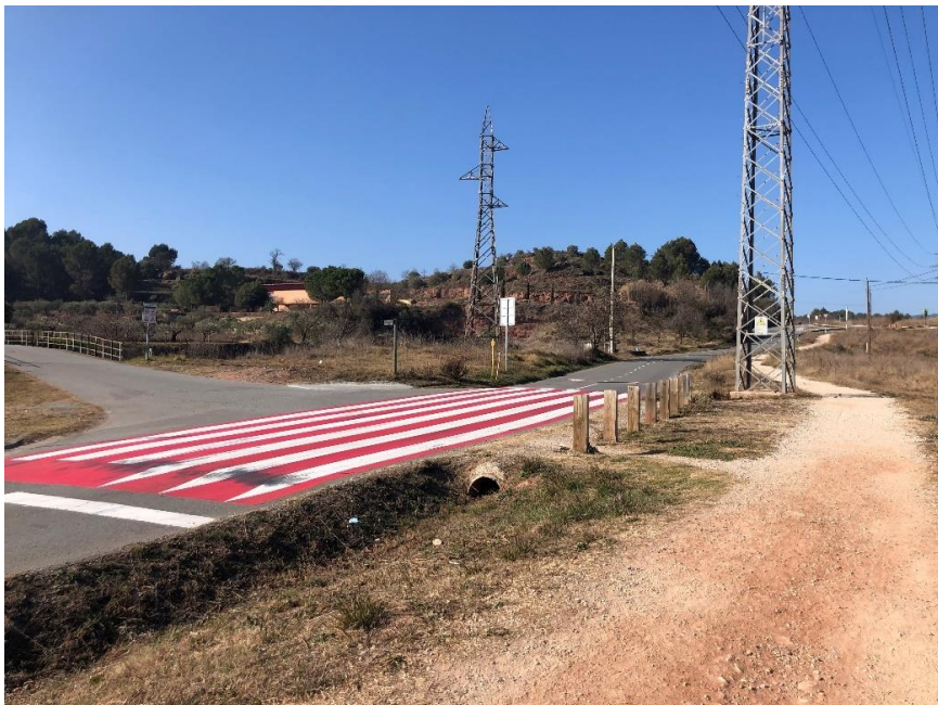
Figura 6. Emplaçament de la futura rotonda on confluiran els carrers A, Torroella i Camí de Rajadell.
