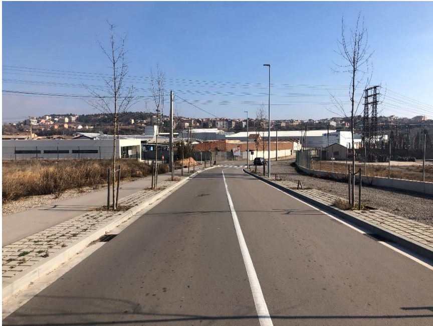
Figura 27. Tram executat del Camí del Suanya (àmbit AU3).
