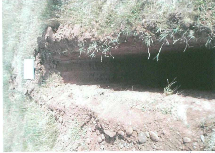
DETALLE DE LA EXCAVACIÓN DE LA CALICATA C-1.
