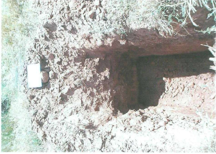
DETALLE DE LA EXCAVACIÓN DE LA CALICATA C-7.
