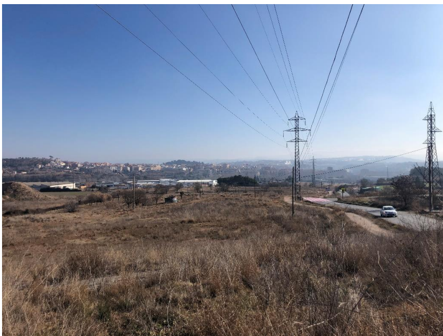
Figura 2. Zona on s'ubicarà l'illa delimitada per l'Avinguda Principal i els carrers A i Torroella.
