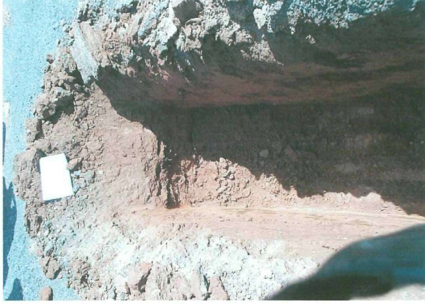
DETALLE DE LA EXCAVACIÓN DE LA CALICATA C-5.
