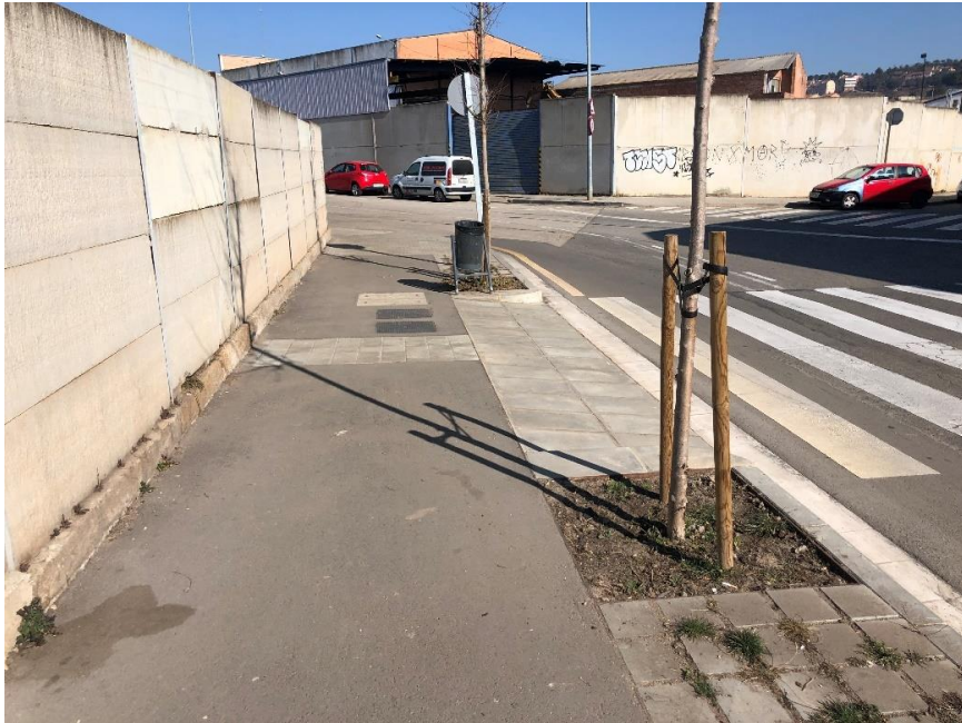
Figura 23. Escocell al tram executat del carrer de la Lemmerz (àmbit AU3).
