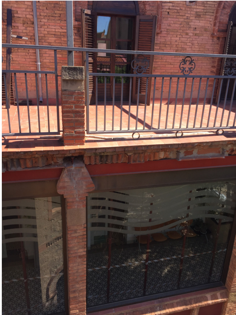
Imatge Terrat Interior amb Unió entre Coberta i Façana
