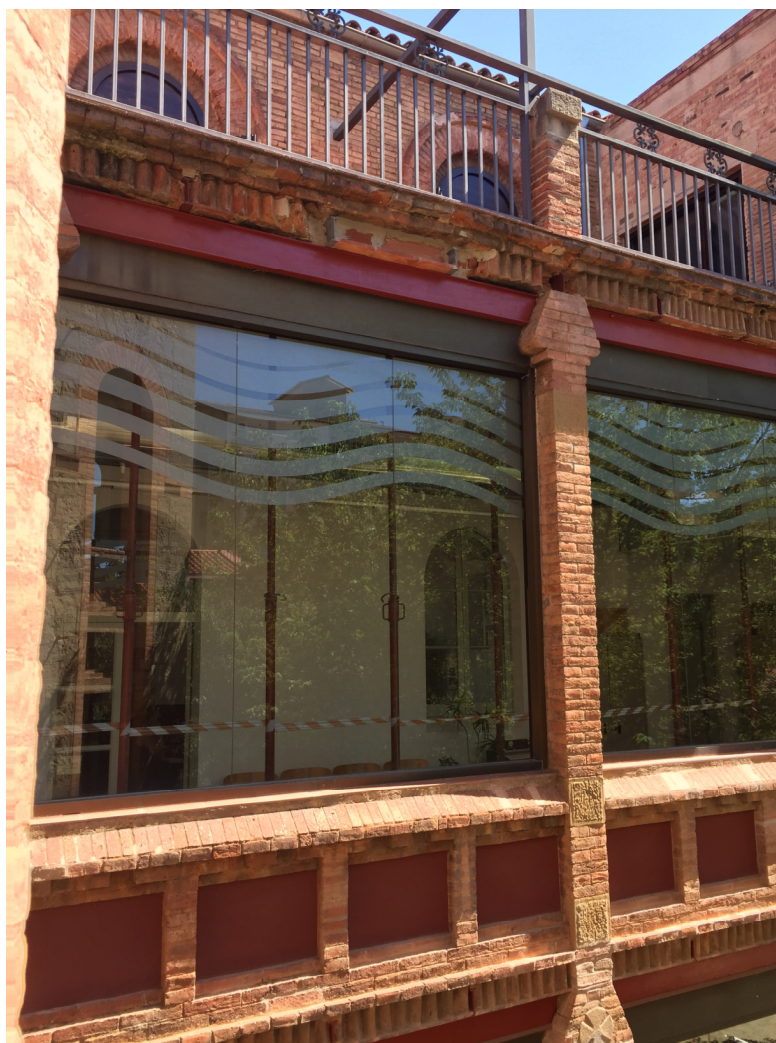
Façana Interior Amb Perfil·eria Estructura Vista
