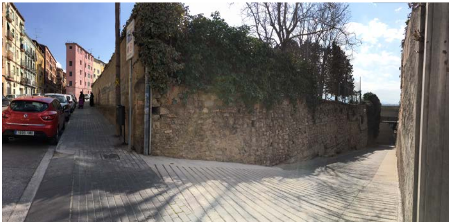
Carrer nou Santa de Clara amb passatge de La Cova
