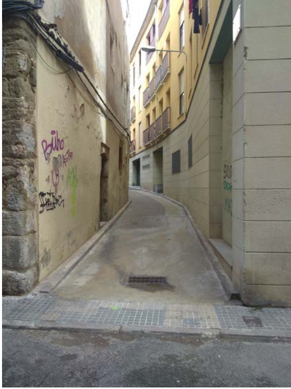
Tram del carrer Llussà a reurbanitzar.
