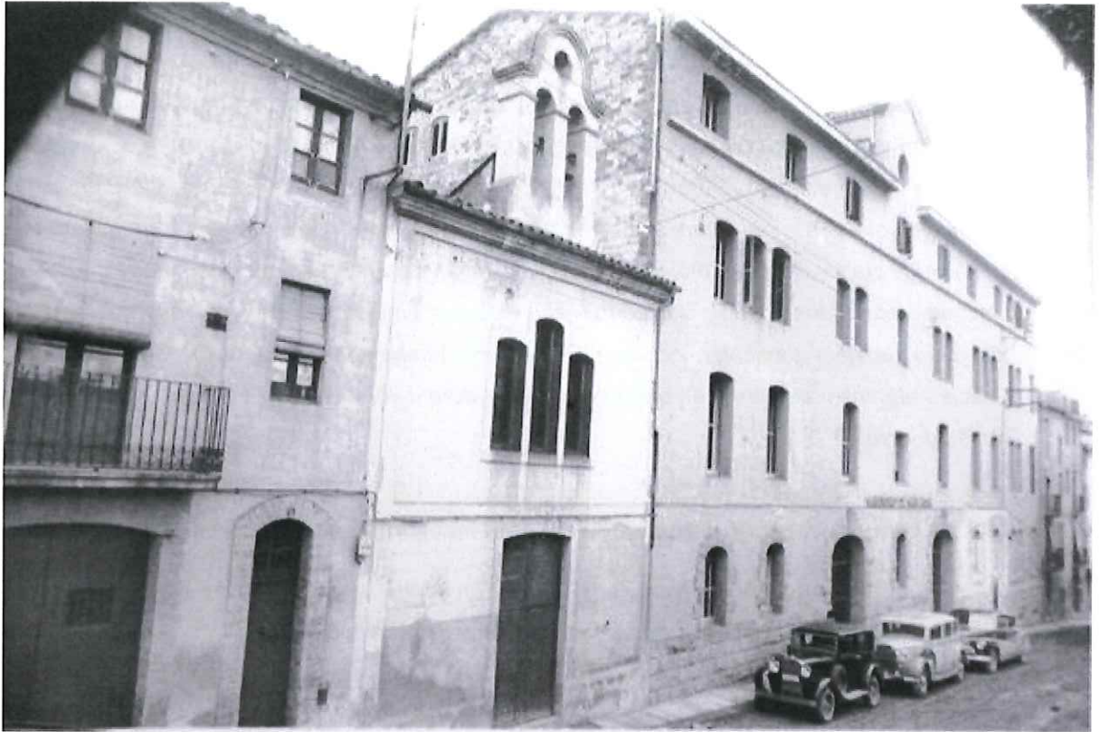
Vista general del conjunt des de la façana del carrer Caputxins, l'any 1931 amb l'església en primer terme i seguidament el sanatori inaugurat el 1929
