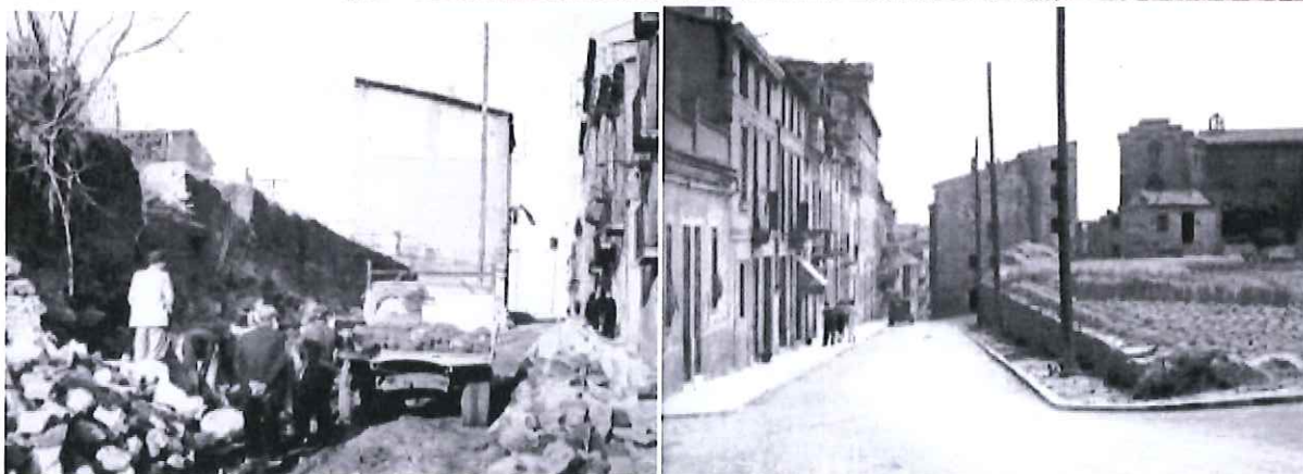
Vistes de les primeres obres per regularitzar les alineacions al carrer Caputxins (Francitorra fotògraf)
