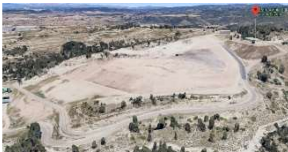
Imatge 1: Vista aèria del dipòsit controlat del Parc Ambiental de Bufalvent.
