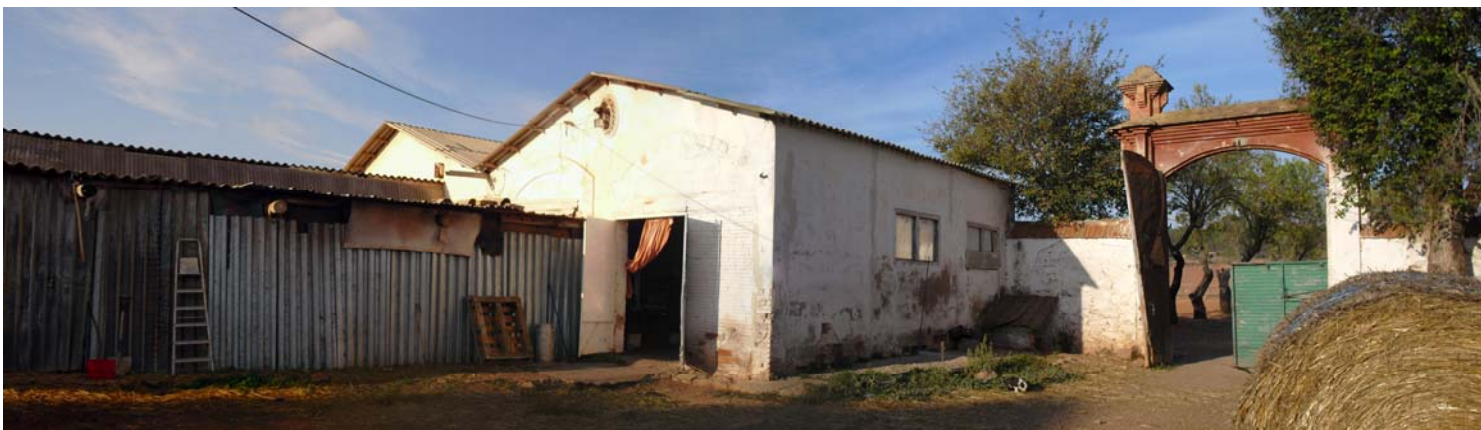
accès principal al recinte
