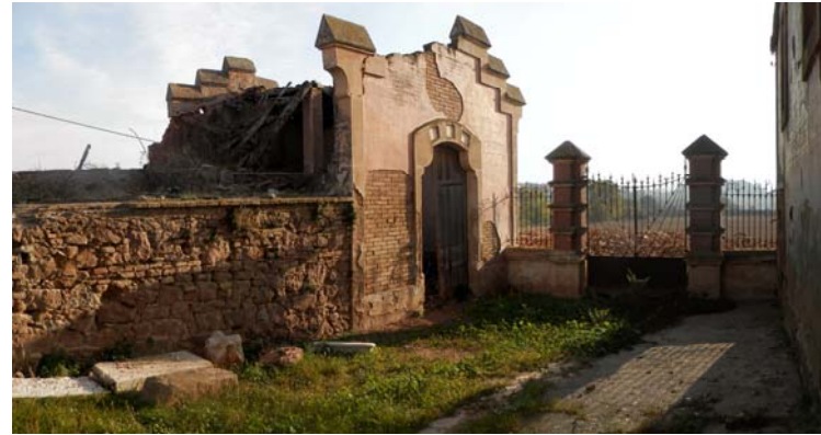
edificació protegida accés posterior
