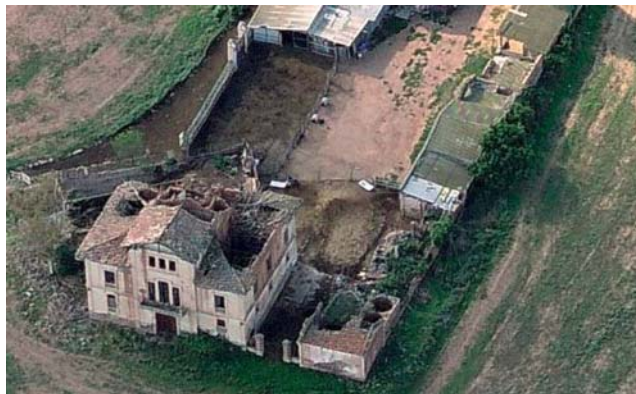
estat actual edificació
