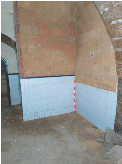
Fig.100.-Fotografia inicial de la Cala parietal 3.
