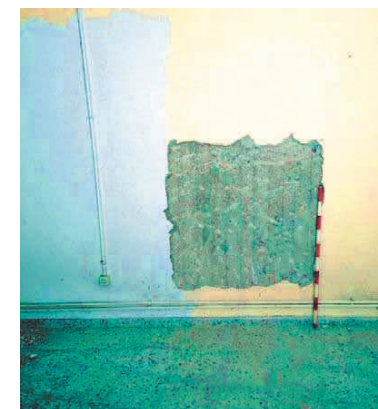
Fig.39.-Fotografia final de la Cala parietal 5
