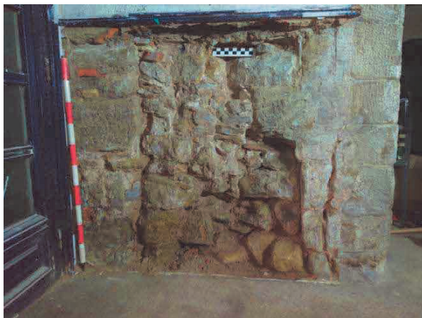
Fig.98.- Fotografia final de la Cala parietal 2.
