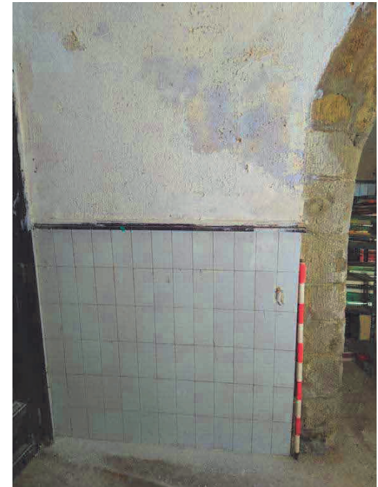
Fig.97.-Fotografia inicial de la Cala parietal 2.
