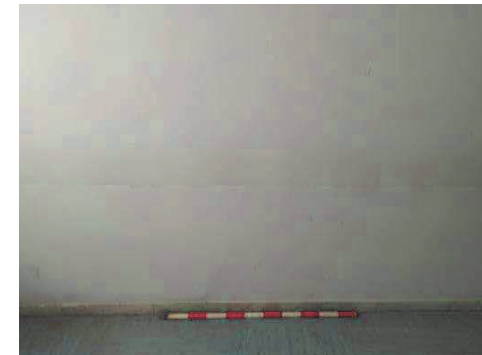
Fig.21.- Fotografia inicial de la cala parietal 1
