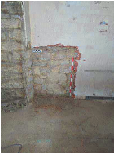
Fig.95.-Fotografia final de la Cala parietal 1.
