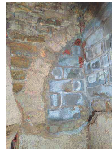
Fig.84.-Imatge d'un arc de mig punt tapiat.
