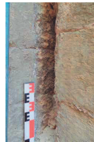
Vista de la cala 2.1. on s'observa el carreuat de l'edifici de Procuradors al qual s'hi entrega el mur dels Jutjats fet amb grans carreus de gres
