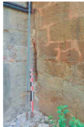
Vista de la cala 2.1. on s'observa el carreuat de l'edifici de Procuradors al qual s'hi entrega el mur dels Jutjats fet amb grans carreus de gres
