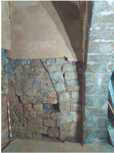
Fig.102.- Fotografia final Cala parietal 3.
