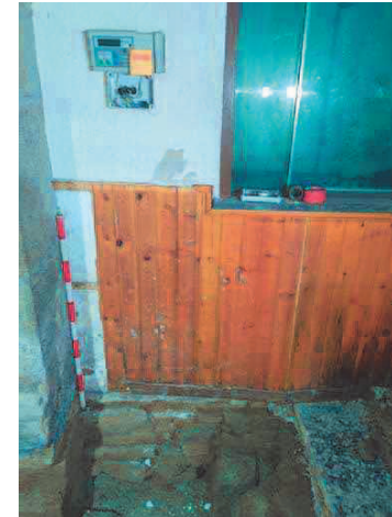
Fig.103.-Fotografia inicial de la Cala parietal 4.
