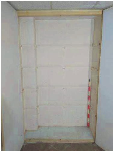
Fig.40.-Fotografia inicial de la Cala parietal 6
