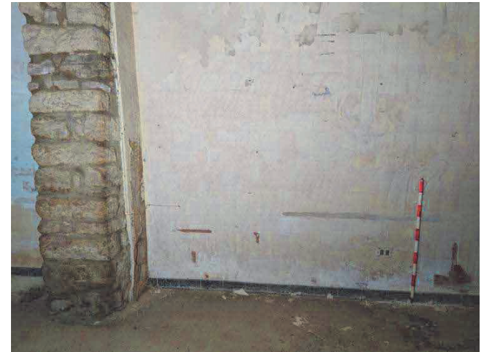
Fig.94.-Fotografia inicial de la Cala parietal 1.
