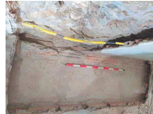
Fig.46.-Fotografia del paviment respecte la cala 1.
