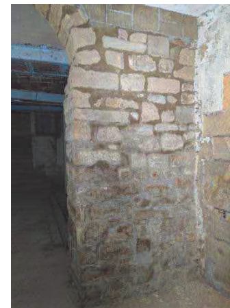
Fig.91.-imatge de com es relaciona l'arc respecte la paret on trobem la porta amb llindes quadrangulares.
