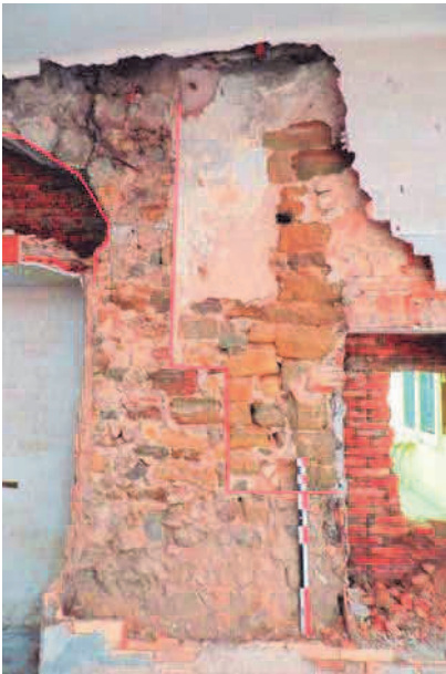
Cala 2.4. on es pot observar l'arrencada de la volta que descarrega sobre un mur avui seccionat.
