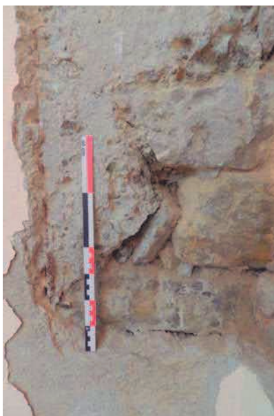
Cala 2.9. Detall de l'entrega del formigó sobre la pedra del mur medieval
