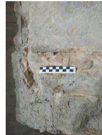
Fig.29.- Detall de la base de l'arc en relació al formigó contemporani.
