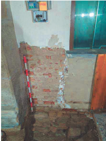
Fig.104.-Fotografia final de la cala parietal 4.
