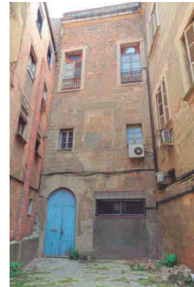
Vista façana principal (de ponent)
