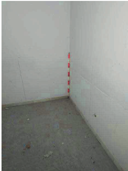
Fig.30.- Fotografia inicial de la Cala parietal 3.
