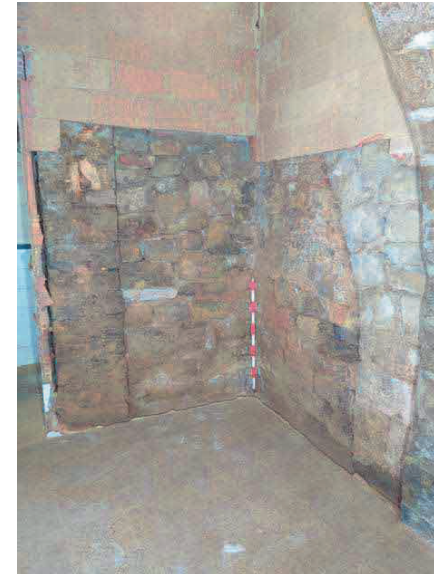
Fig.101.-Fotografia final Cala parietal 3.
