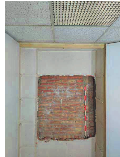
Fig.41.- Fotografia final de la cala 6.
