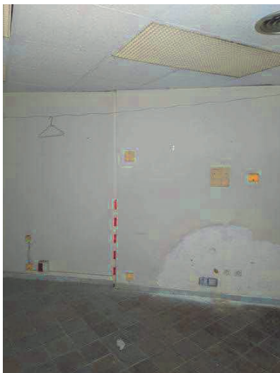
Fig.42.- Fotografia inicial de la Cala 7.
