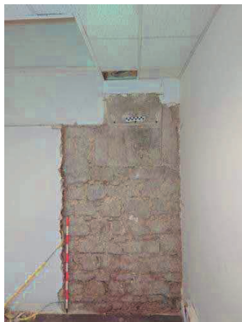
Fig.36.-Fotografia final de la Cala parietal 4.
