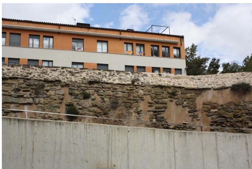
Segon segment del tram de muralla de llevant
