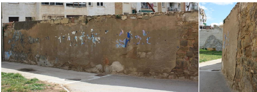
Imatge frontal i lateral de l'arrebossat modern aplicat sobre l'estructura original
