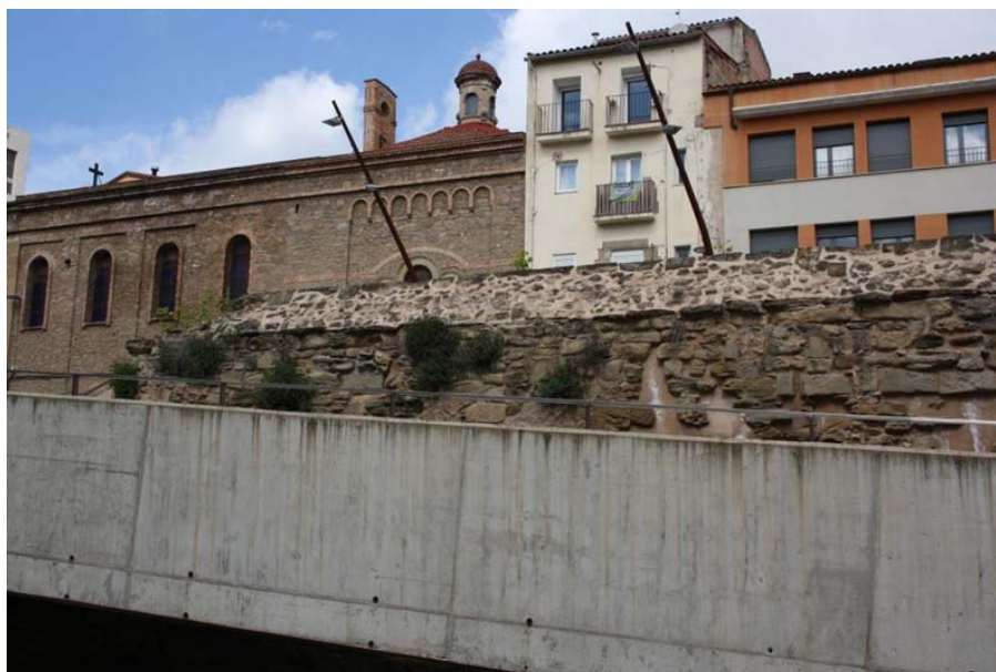
Detall del coronament de la muralla, clarament diferenciat de l'estructura
