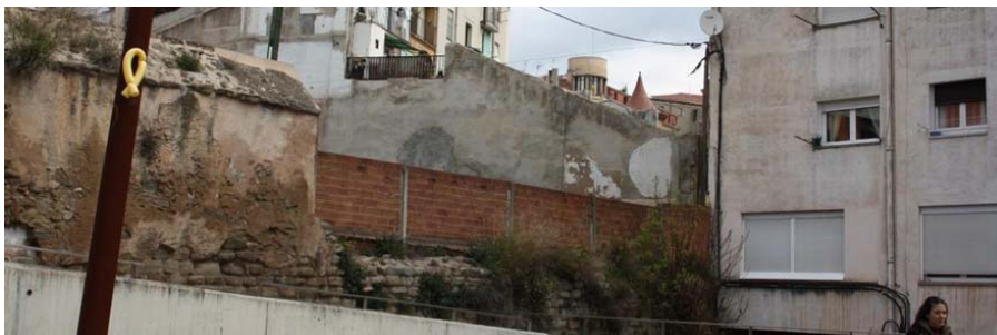
Imatge on s'observa el tancament de totxanes
