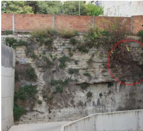
Imatge del mur amb la tanca a substituir i la figuera a eliminar
