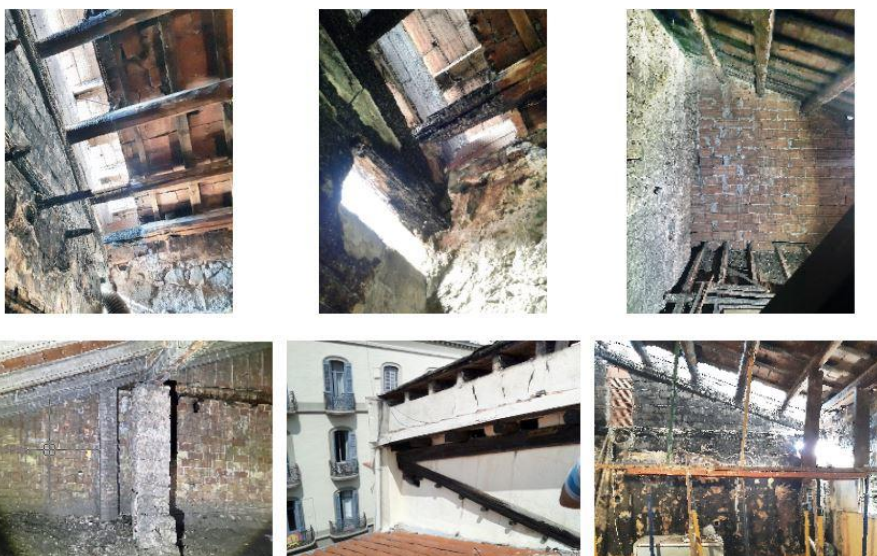
Imatges de l'estat actual
