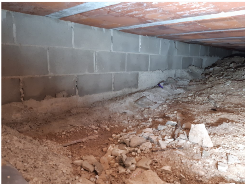
04 - VISTA INFERIOR DE FORJAT
