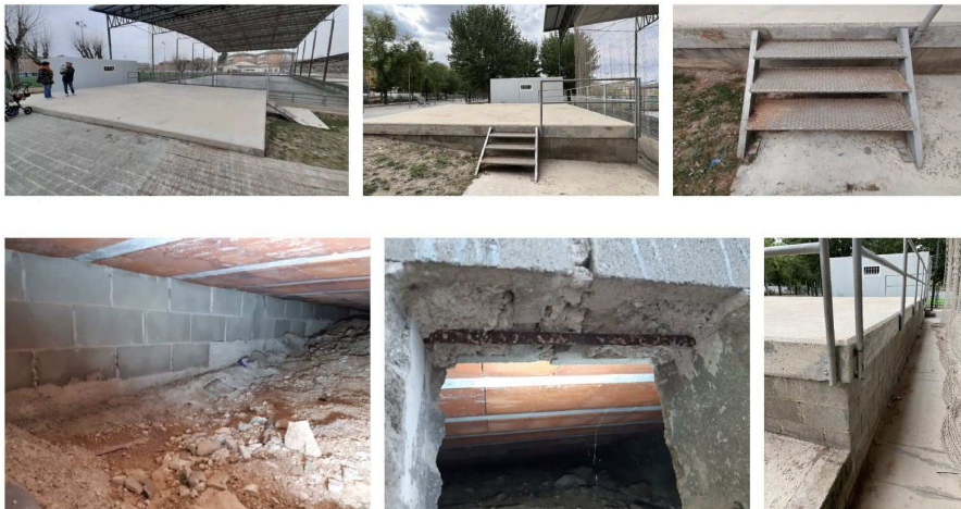
Imatges de l'estat actual
