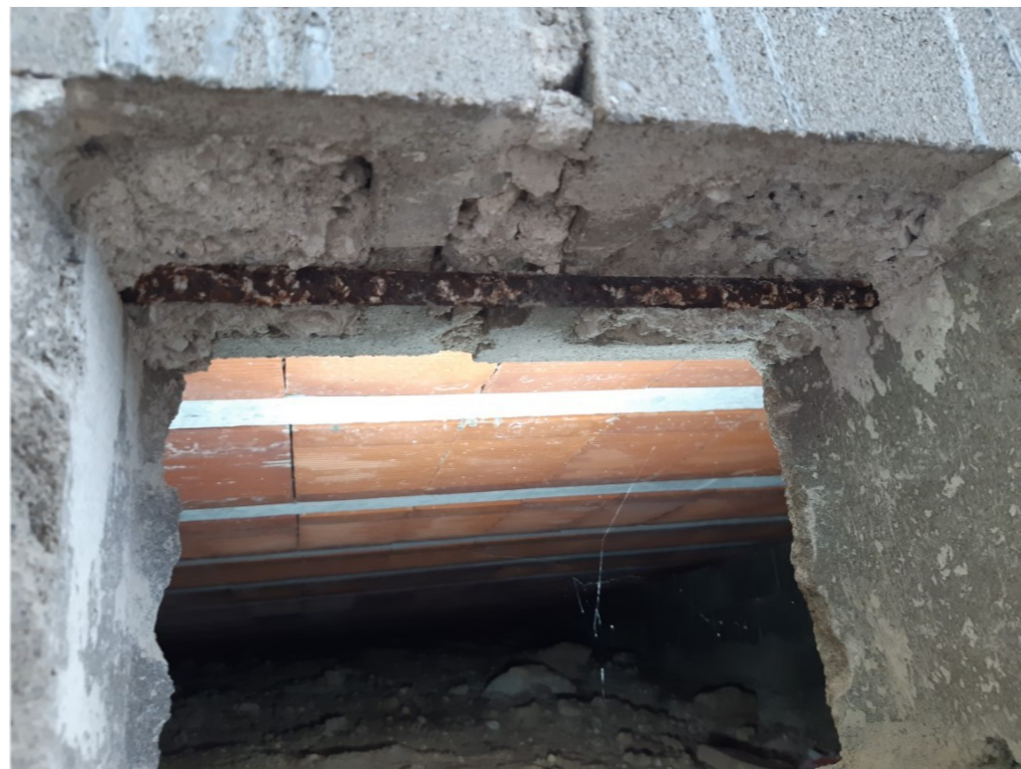
05 - ARMAT LONGITUDINAL DE BLOC DE FORMIGÓ
