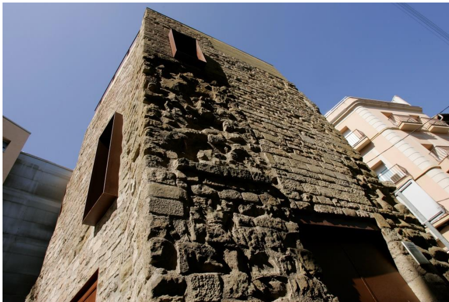
Portal de Sobrerroca
