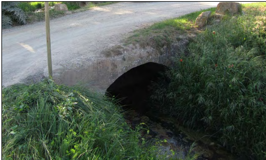
Figura 71. Pont del torrent de l'Oller (Punt 30).
