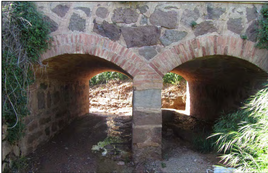
Figura 78. Pont del barranc de la Rasa (Punt 39).
