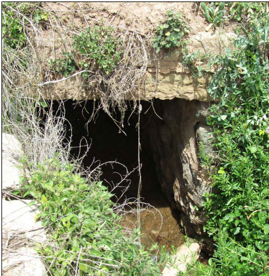
Figura 45. Pont del torrent del Grau, vista d'aigües avall (Punt 4).
