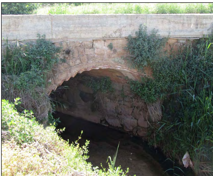
Figura 76. Pont del torrent Innominat 4, vista d'aigües avall (Punt 35).
