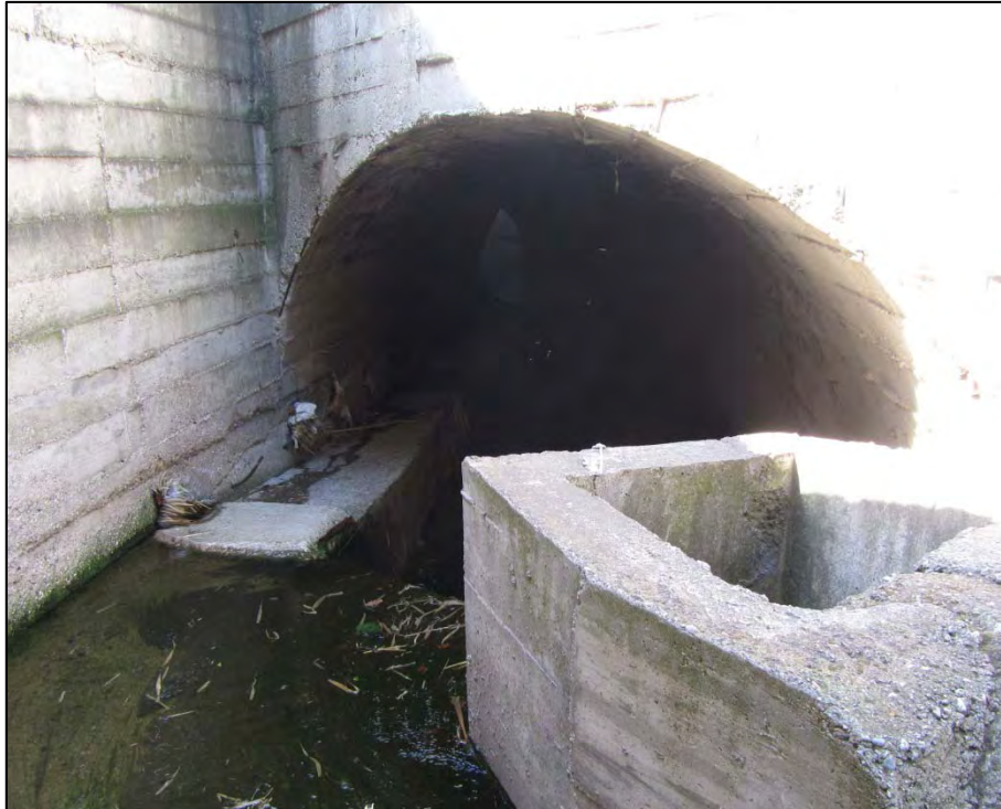
Figura 67. Pont del barranc dels Llops, vista d'aigües amunt (Punt 26).
