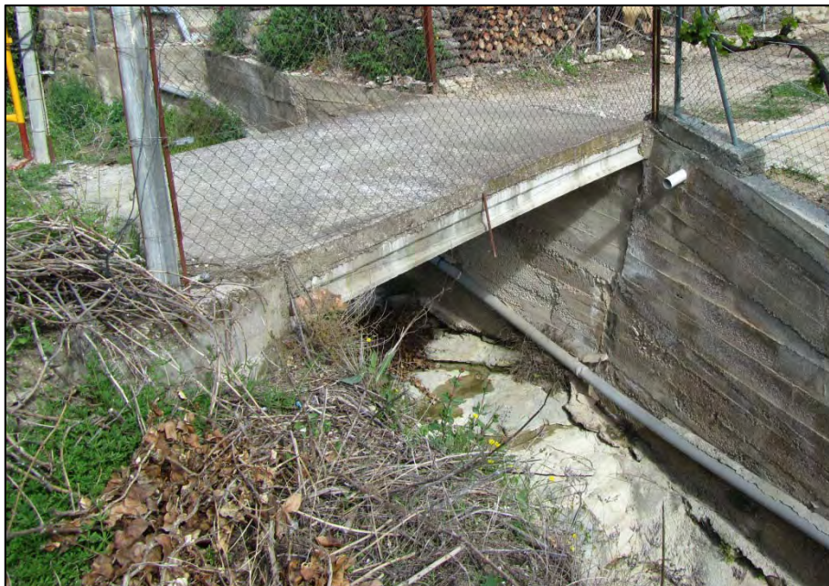
Figura 57. Pont del torrent Innominat 3, vista d'aigües avall (Punt 16).
