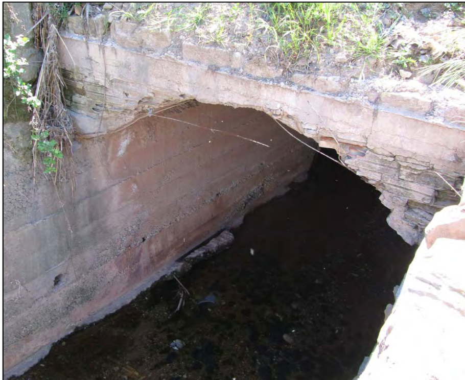
Figura 77. Pont del torrent Innominat 4 (Punt 36).
