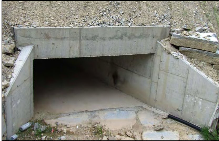
Figura 54. Pont del torrent Innominat 1, vista d'aigües amunt (Punt 13).
