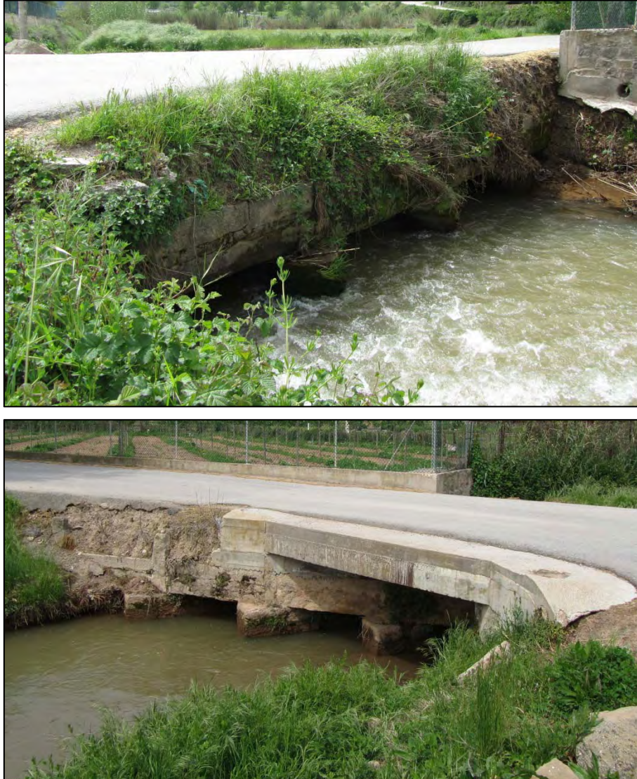
Figura 47. Pont del torrent del Guix (Punt 6).
