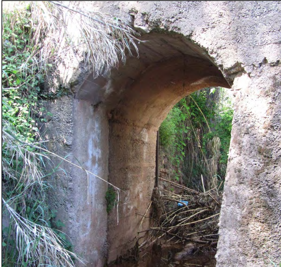
Figura 79. Pont del barranc de la Rasa (Punt 40).
