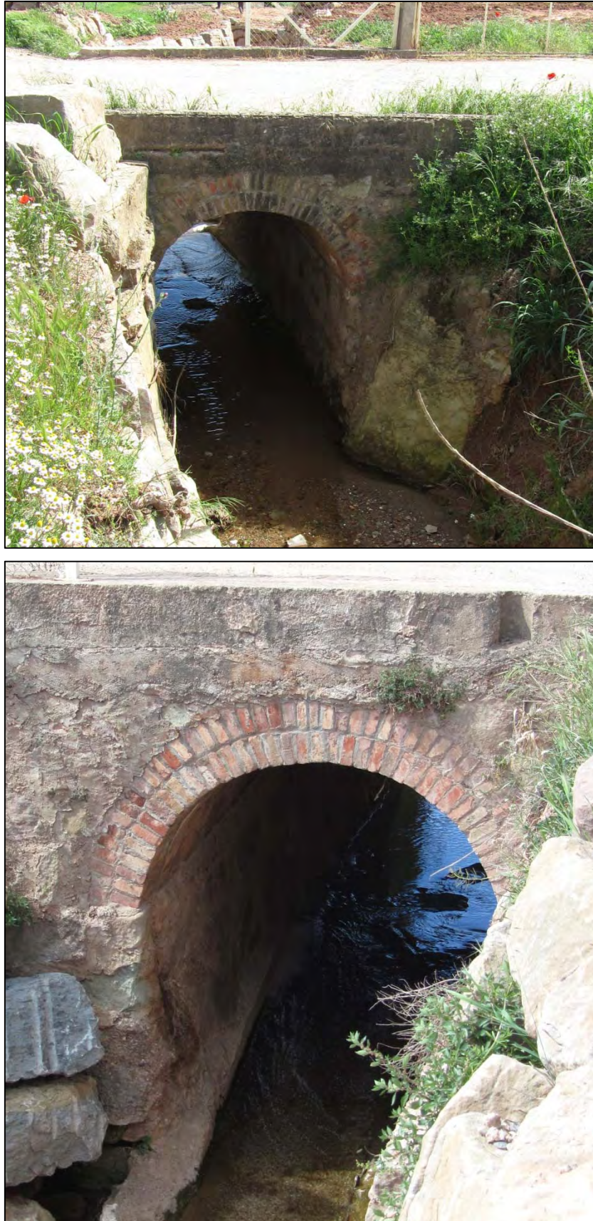
Figura 59. Pont del torrent de Mas d'en Pla (Punt 18).
