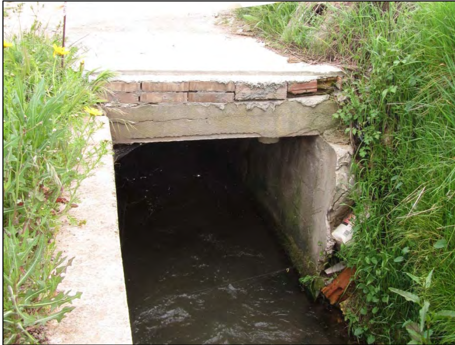
Figura 43. Pont del torrent del Guix, vista aigües amunt (Punt 2).
