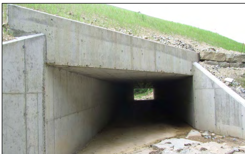
Figura 56. Pont del torrent Innominat 1, vista d'aigües amunt (Punt 15).
