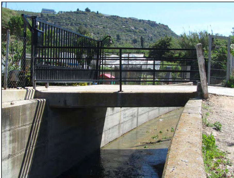
Figura 68. Pont del barranc dels Llops, vista d'aigües avall (Punt 27).
