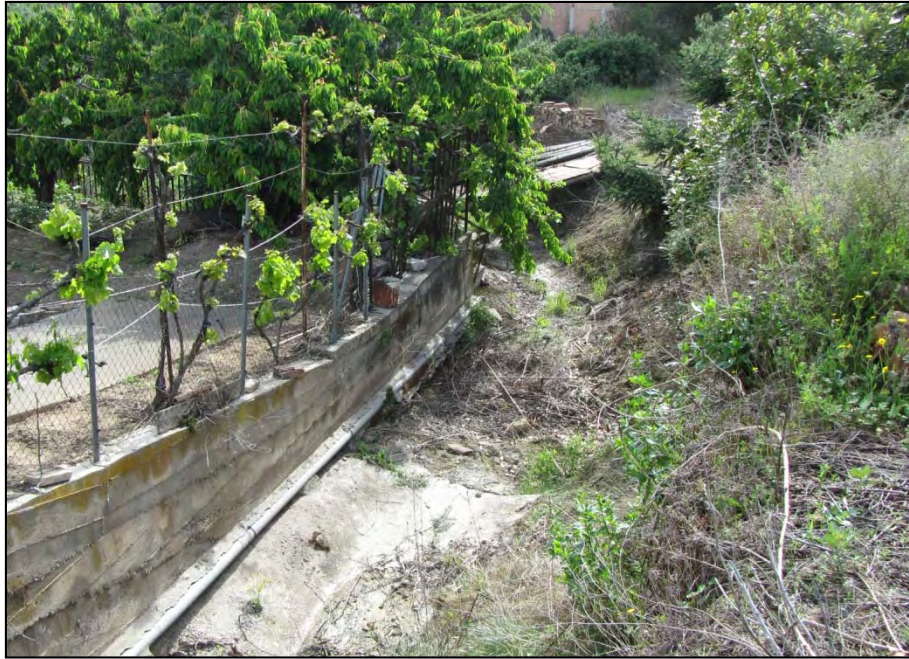
Figura 35. Vista de la llera del torrent Innominat 3 (d'aigües amunt, a aigües avall).
