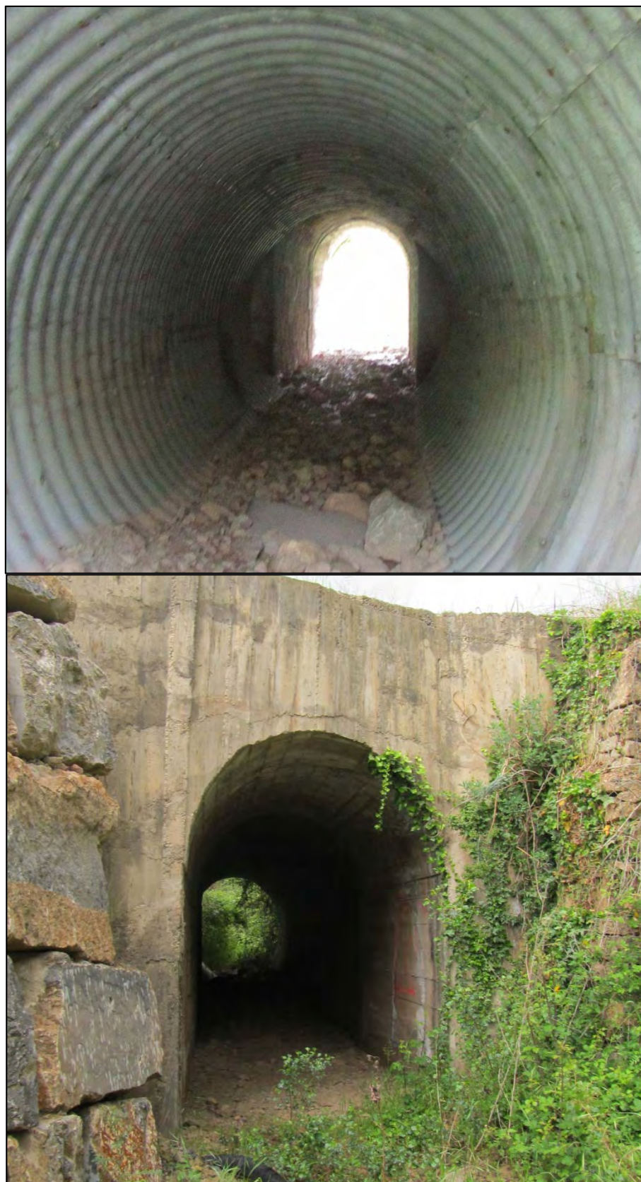
Figura 53. Pont del torrent Innominat 1 (Punt 12).
