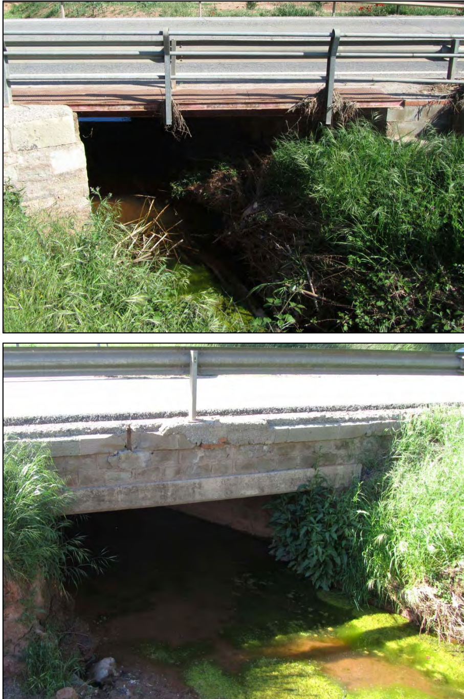
Figura 72. Pont del torrent de l'Oller (Punt 31).
