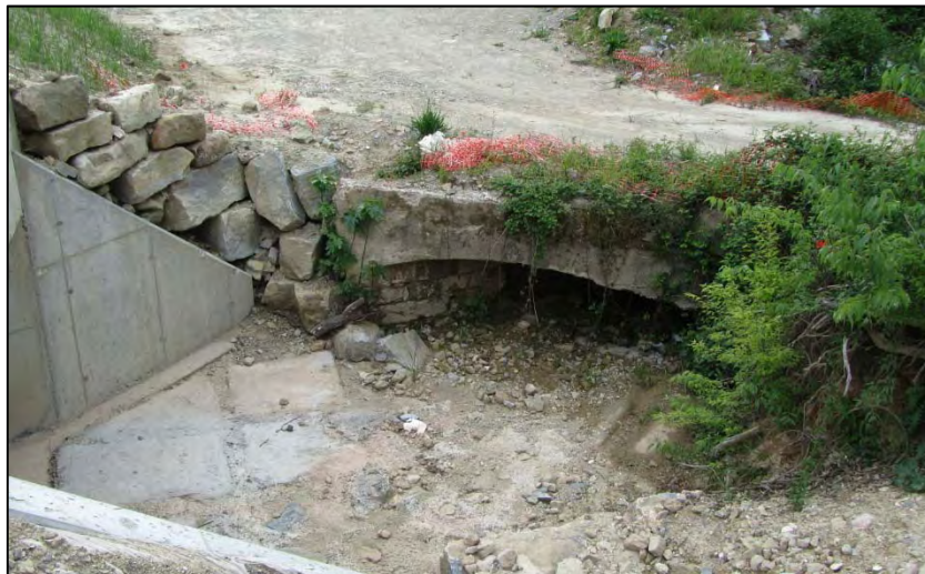
Figura 55. Pont del torrent Innominat 1, vista d'aigües amunt (Punt 14).
