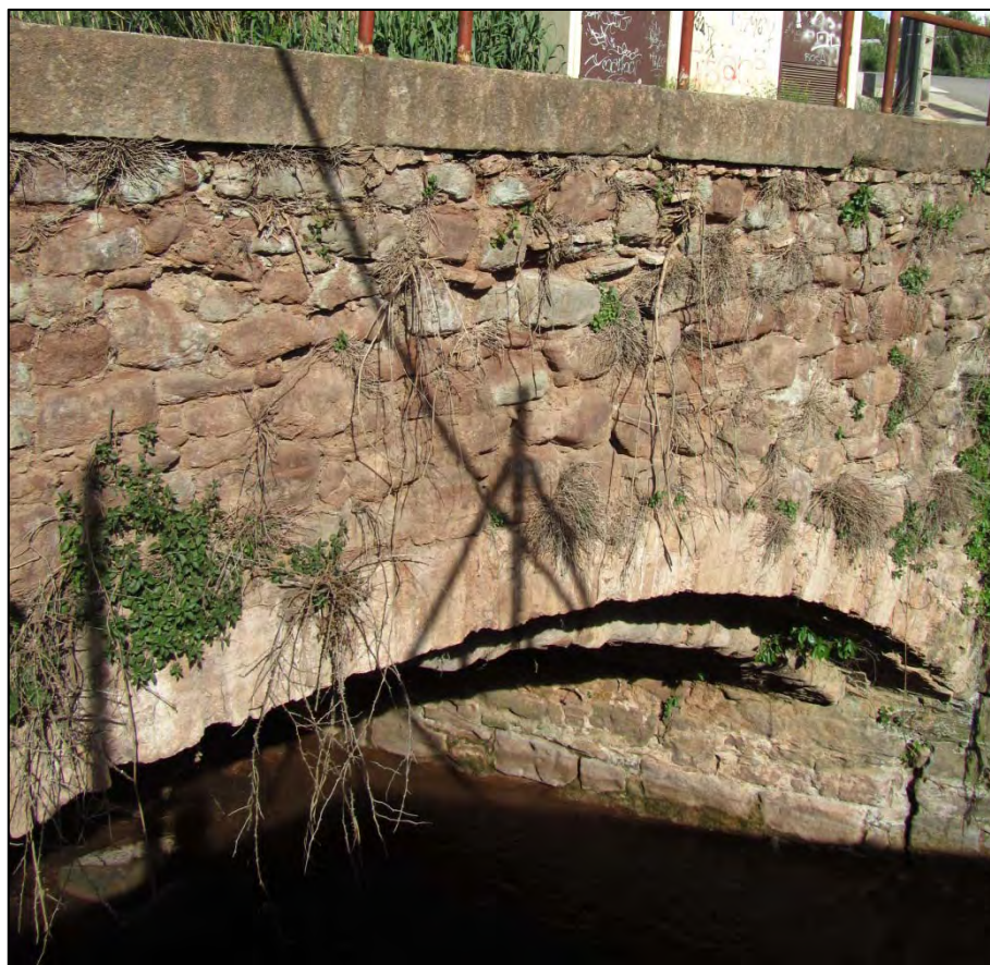
Figura 62. Pont del torrent de Mas d'en Pla, vista d'aigües avall (Punt 21).
