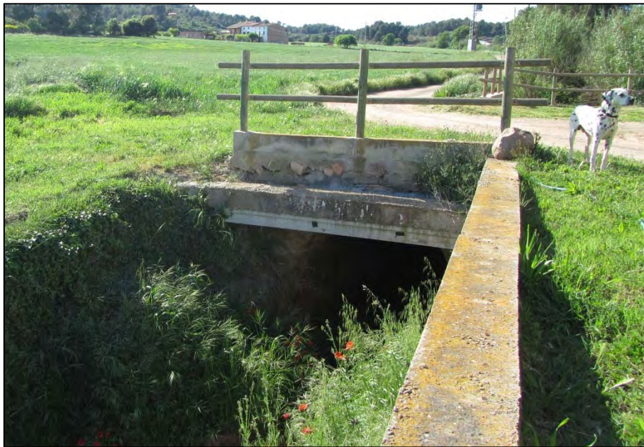
Figura 70. Pont del rasot de la Peça, vista d'aigües avall (Punt 29).
