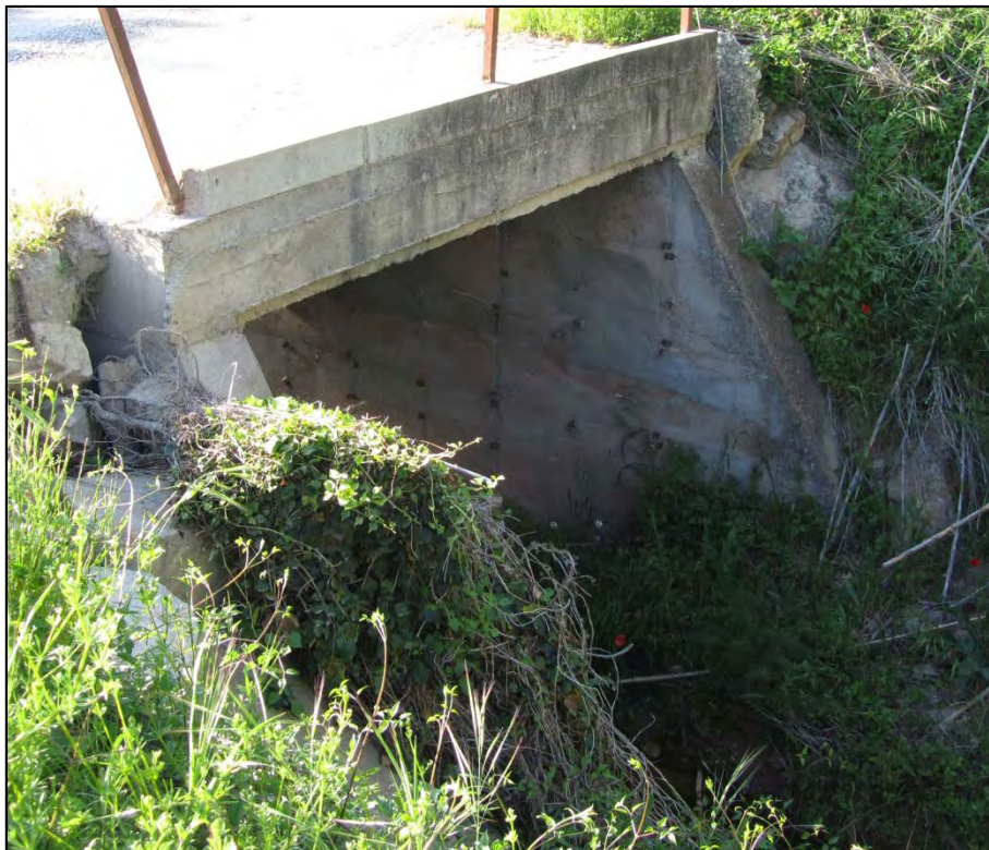
Figura 75. Pont del torrent de l'Oller, vista d'aigües avall (Punt 34).
