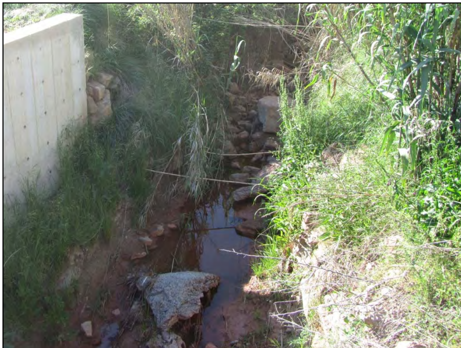
Figura 38. Vista de la llera del rasot de la Peça (d'aigües amunt, a aigües avall).
