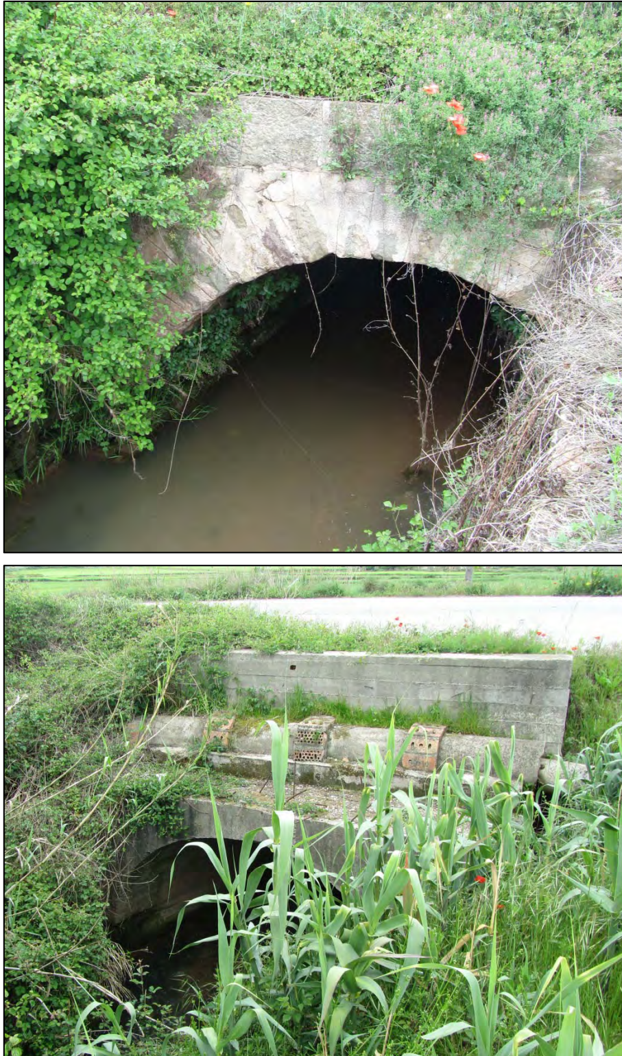
Figura 48. Pont del torrent de Viladordis (Punt 7).
