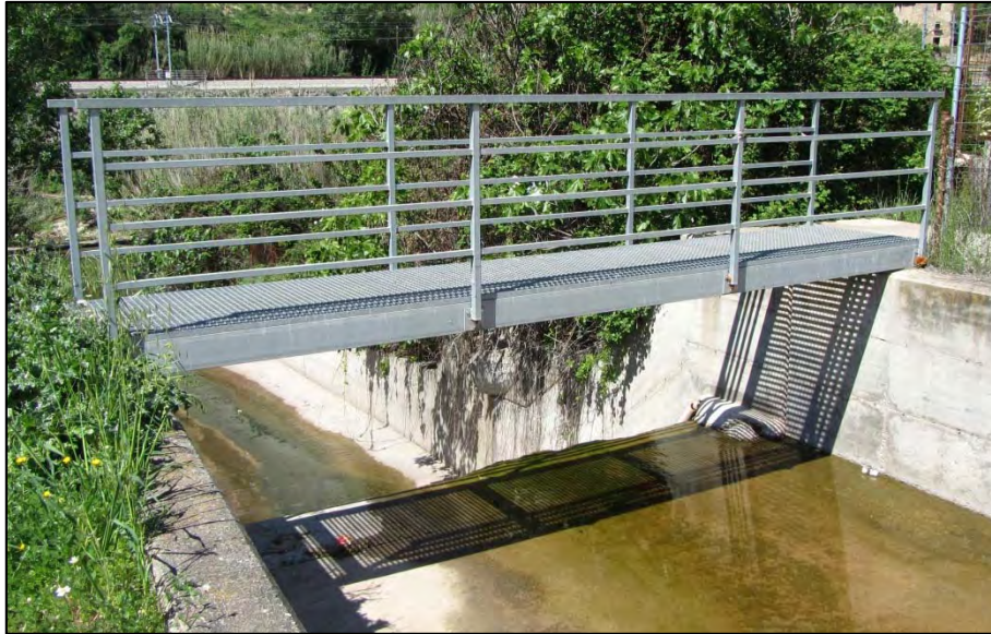
Figura 69. Pont del barranc dels Llops, vista d'aigües amunt (Punt 28).
