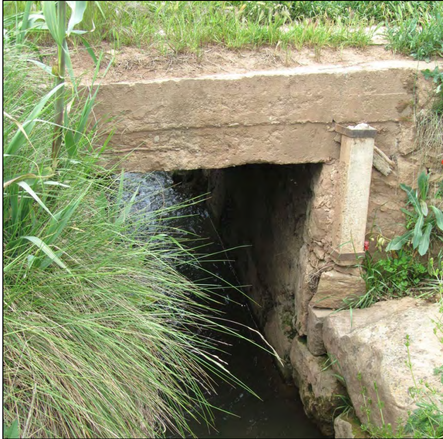
Figura 42. Pont del torrent del Guix, vista d'aigües amunt (Punt 1).
