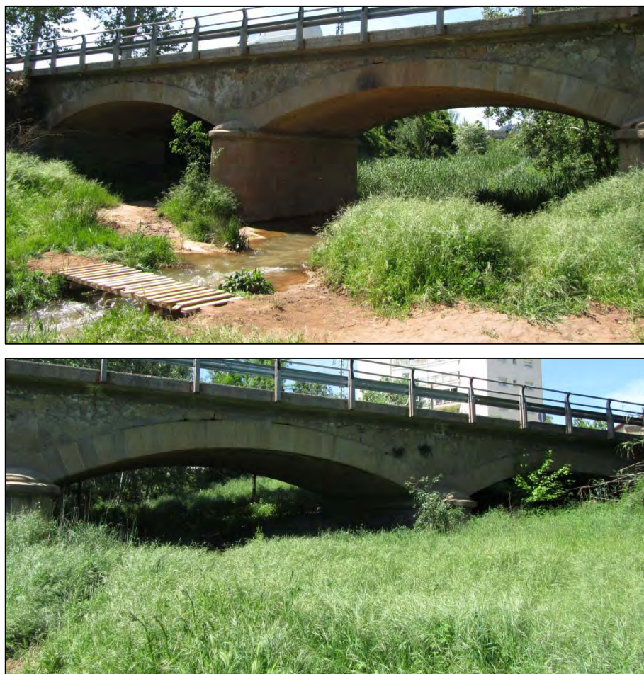
Figura 80. Pont de la riera de Rajadell, vista d'aigües avall (Punt 41).
