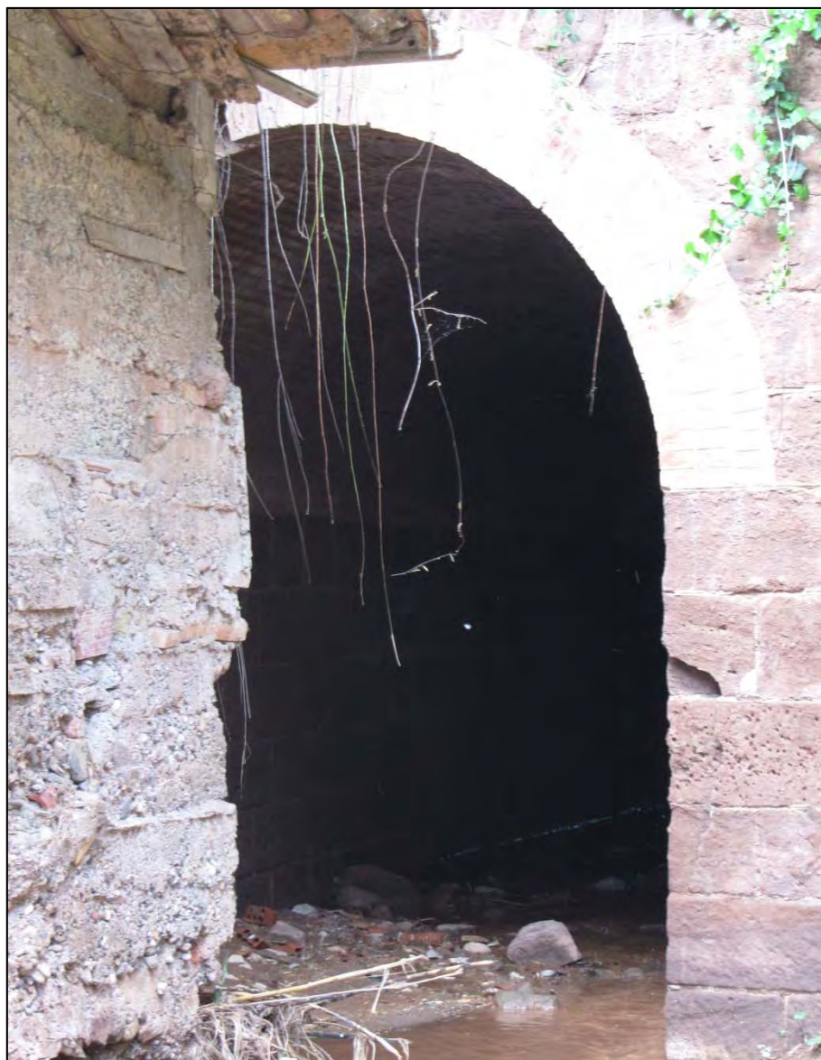
Figura 61. Pont del torrent de Mas d'en Pla, vista d'aigües avall (Punt 20).
