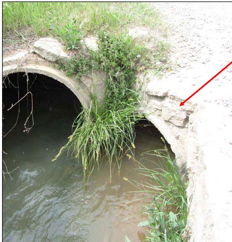
Figura 46. Pont del torrent del Grau (Punt 5). Zona de confluència entre el torrent del Guix i el torrent del Grau. La fletxa indica a quina estructura correspon.
