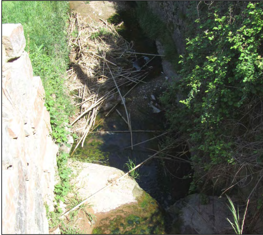
Figura 37. Vista de la llera del torrent Innominat 4 (d'aigües amunt, a aigües avall).
