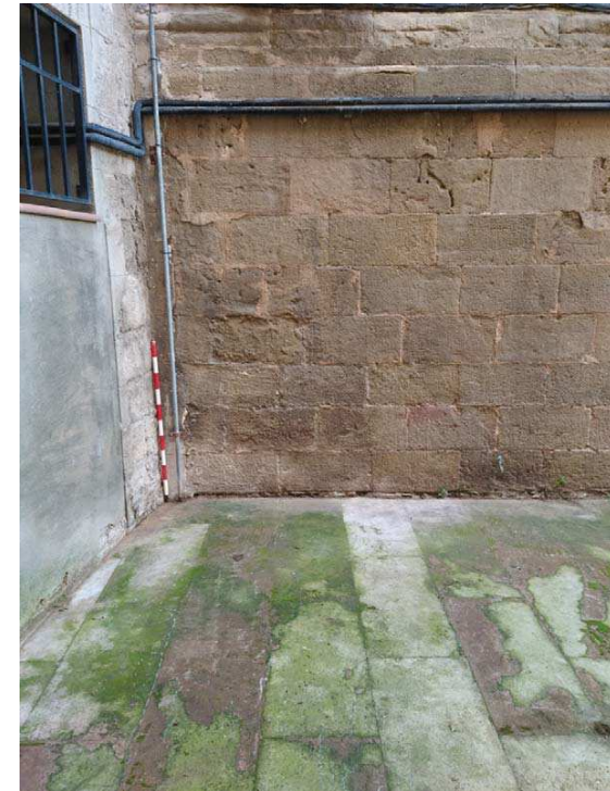
Fig.58.-Fotografia inicial del sondeig 3, en relació al mur nord del cos principal de l'edifici de Baixada de la Seu nº2.
