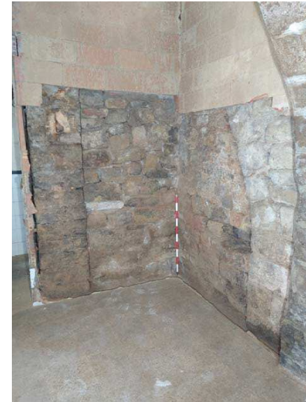
Fig.101.-Fotografia final Cala parietal 3.
