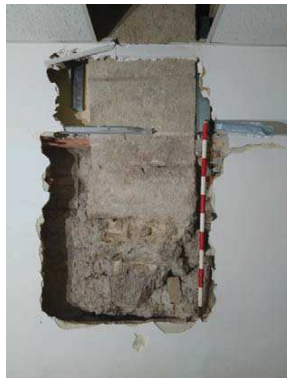
Fig.27.- Foto final de la Cala parietal 2 on s'observa la continuació de l'arc al sostre.
