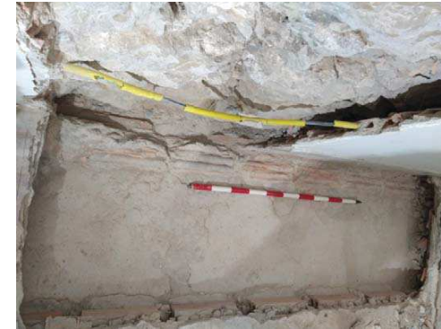
Fig.46.-Fotografia del paviment respecte la cala 1.
