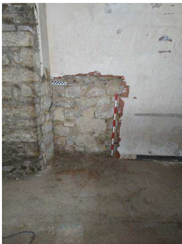
Fig.95.-Fotografia final de la Cala parietal 1.
