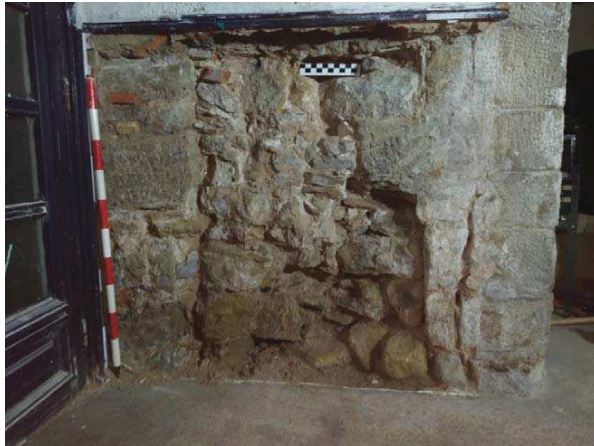
Fig.98.- Fotografia final de la Cala parietal 2.
