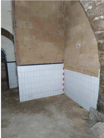
Fig.100.-Fotografia inicial de la Cala parietal 3.
