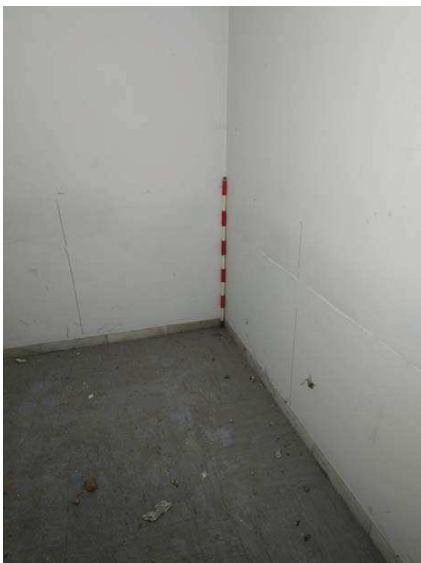
Fig.30.- Fotografia inicial de la Cala parietal 3.
