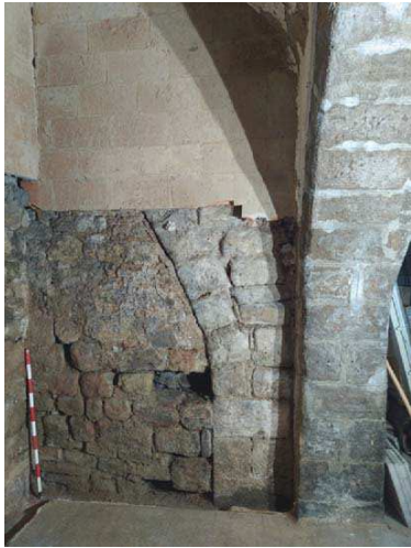
Fig.102.- Fotografia final Cala parietal 3.
