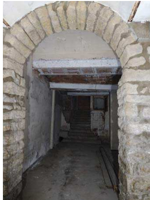
Fig.89.-imatge de l'arc de mig punt.
