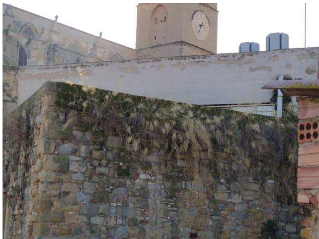
Fig.14.-Detall del mur a la vessant nord del cos principal de l'edifici.
