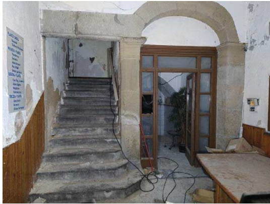
Fig.78.-Vestíbul de l'edifici de Galcerán Andreu núm.6-8 amb arc de mig punt i columnes de pedra (probable antic portal).
