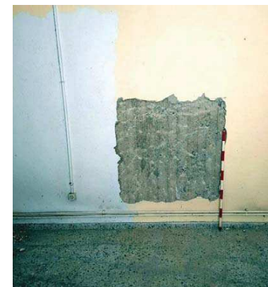
Fig.39.-Fotografia final de la Cala parietal 5
