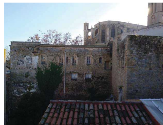
Fig.16.-Imatge del mur nord de la "sala gòtica"
