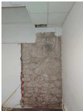
Fig.36.-Fotografia final de la Cala parietal 4.
