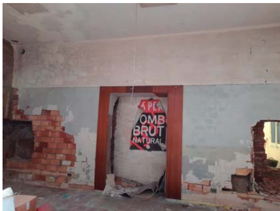
Vista de l'espai del sondeig 2.4 abans de l'actuació
