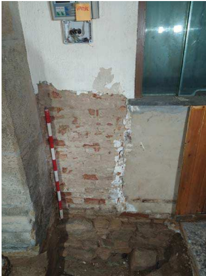
Fig.104.-Fotografia final de la cala parietal 4.
