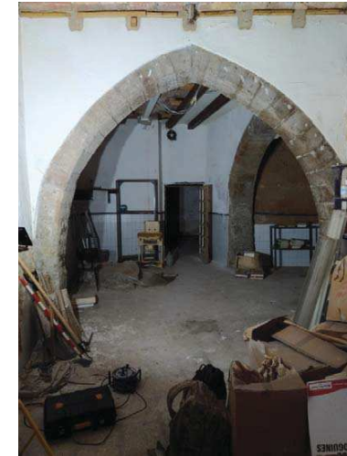
Fig.80.- Imatge d'un dels arcs apuntats de l'antic edifici de la Creu Roja.
