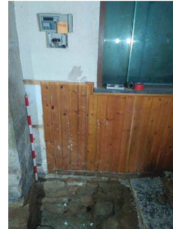
Fig.103.-Fotografia inicial de la Cala parietal 4.
