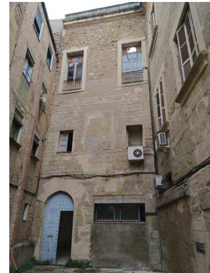
Fig.56.- Visió general de la façana de l'edifici de l'Il·lustre col·legi de procuradors, conjuntament amb els edificis amb que es relaciona.
