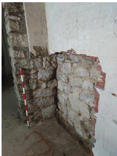
Fig.96.-Fotografia final de la Cala parietal 1, amb especial èmfasi en les relacions físiques entre el mur i l'arc.
