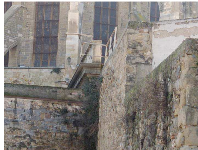
Fig.13.-Detall del mur a la vessant nord est, que es relaciona amb la sala gòtica.
