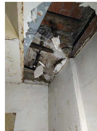
Fig.87.- Arc amb volta just a sobre de la porta amb llindes quadrangulars.
