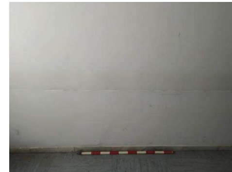
Fig.21.- Fotografia inicial de la cala parietal 1
