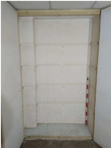
Fig.40.-Fotografia inicial de la Cala parietal 6
