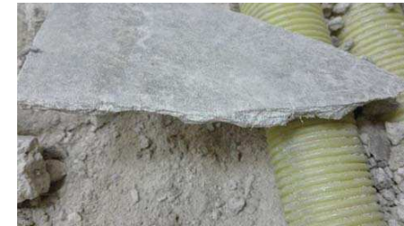
Fig.129.- Fotografia d'un dels sondejos de l'interior de Jutjats Vells on va aparèixer el fibrociment.
