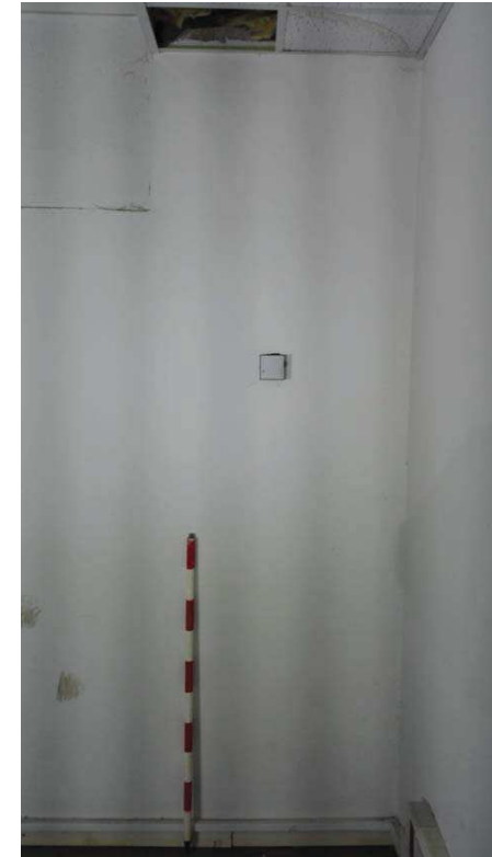
Fig.35.-Fotografia inicial de la Cala parietal 4.
