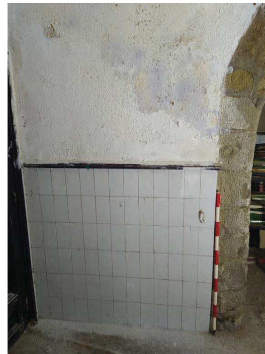
Fig.97.-Fotografia inicial de la Cala parietal 2.
