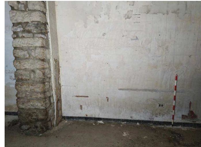
Fig.94.-Fotografia inicial de la Cala parietal 1.
