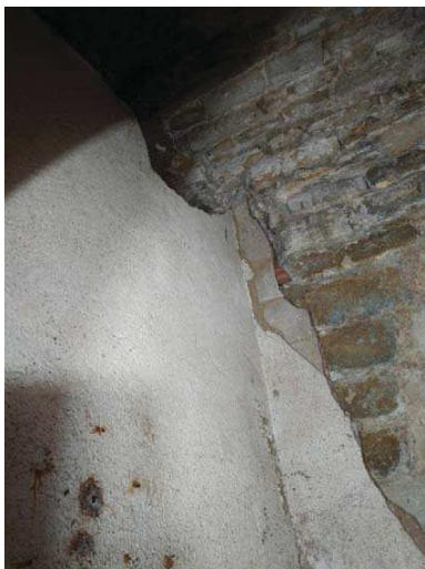
Fig.85.-Detall de la factura de pedra dels murs circumdants als arcs de mig punt.
