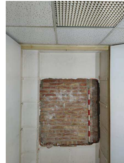
Fig.41.- Fotografia final de la cala 6.
