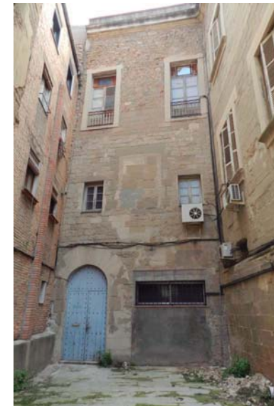
Vista façana principal (de ponent)
