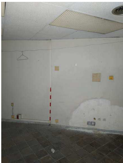
Fig.42.- Fotografia inicial de la Cala 7.
