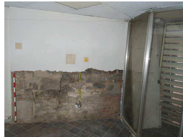
Fig.43.- Fotografia final de la Cala 7.
