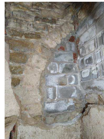
Fig.84.-Imatge d'un arc de mig punt tapiat.
