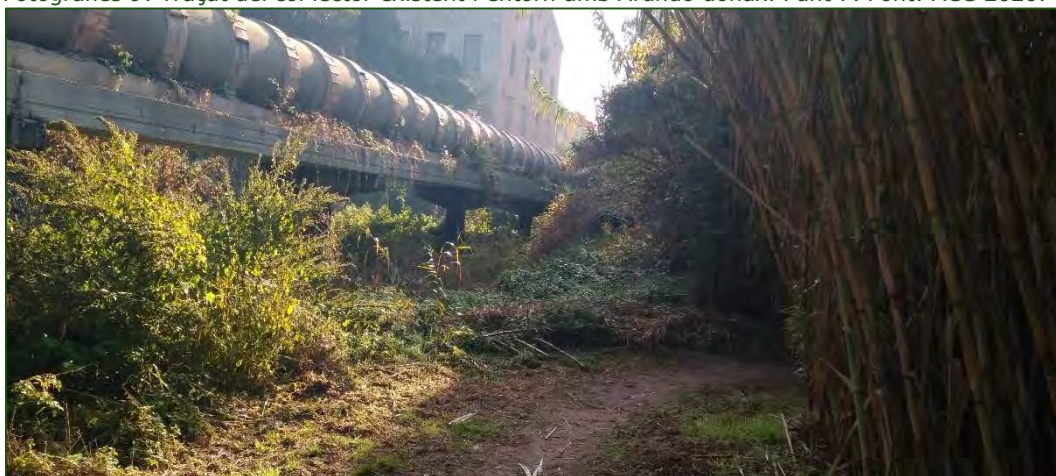
Fotografies 9: Traçat del col·lector existent i entorn amb Arundo donax . Punt 7. Font: ACC 2020.
