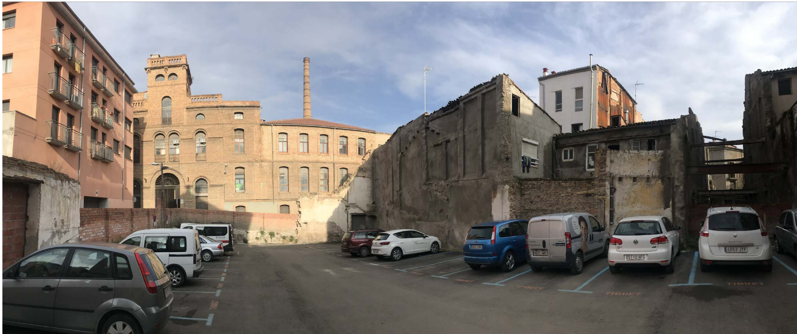
F1. VISTA INTERIOR SOLAR ILLA C/ DAMA + PLAÇA INFANTS ( ACTUALMENT APARCAMENT EN ROTACIÓ I ON ESTÀ PREVIST NOU ESPAI PÚBLIC DEL PMU DAMA DAVANT LA FÀBRICA DE L'ANÒNIMA ) . VISTA MITGERA ANTIC CINEMA GOYA ( ENDERROCAT ) I FAÇANES PATI INTERIOR D'ILLA
