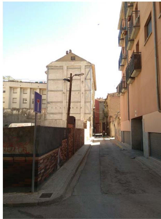
F6. VISTA C/ DAMA DES DEL CARRER LLUSSÀ
