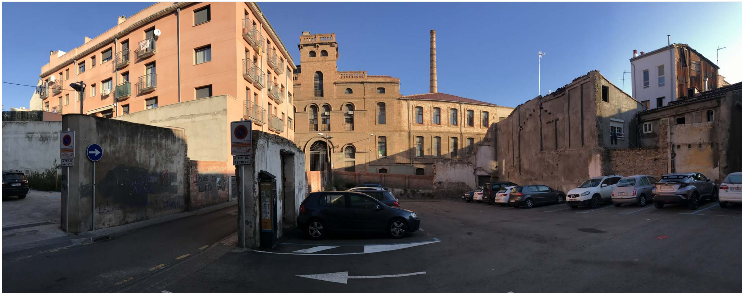
F1. VISTA PANORÀMICA SOLAR ILLA C/ DAMA + C/ LLUSSÀ ( ACTUALMENT APARCAMENT EN ROTACIÓ ) . VISTA FAÇANES POSTERIORIS PATI D'ILLA C/DAMA + C / LLUSSÀ I FAÇANA PRINCIPAL L'ANÒNIMA ( ON ES PREVEU NOU ESPAI PÚBLIC )
