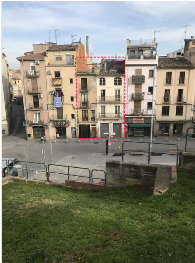
F1. VISTA GENERAL DES DE LA PLAÇA DEL MILCENTENARI
