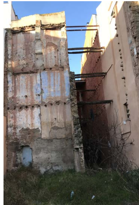
F5. FAÇANES PATI ILLA DELS DOS EDIFICIS PLAÇA INFANTS INCLOSSOS DINS DEL PMU DAMA ( EDIFICACIONS A ENDERROCAR )
