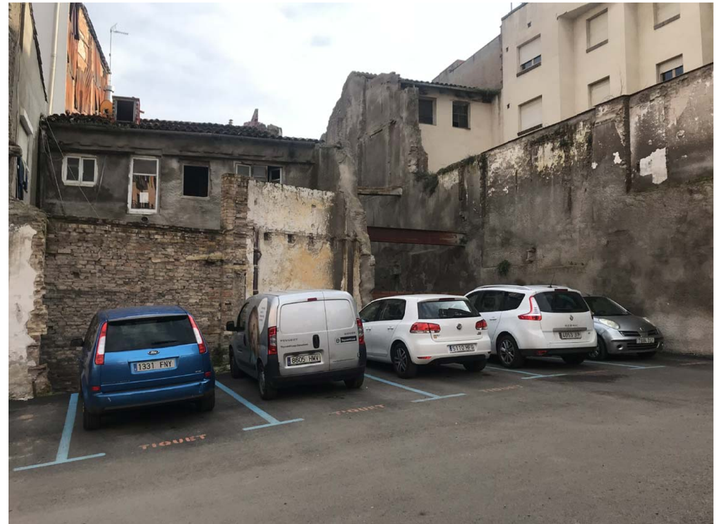
F2. FAÇANA INTERIOR D'ILLA C/ SANT ANDREU + C/ LLUSSÀ ( AMB ACCÉS ANTIC CINEMA GOYA A L'ESQUERRA, ACTUALMENT ENDERROCAT)
