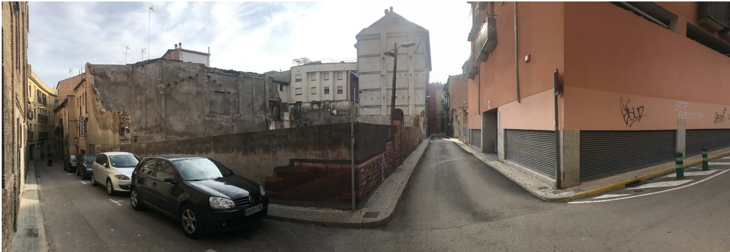
F1. VISTA PANORÀMICA XAMFRÀ C/ DAMA + C/ LLUSSÀ ( ON ES PREVEU NOU ESPAI PÚBLIC ) AMB LA MITGERA I LA FAÇANA INTERIOR DE LA RESIDÈNCIA DEL SAGRAT COR AL FONS, ON S'HA D'INTEGRAR LA NOVA EDIFICACIÓ PREVISTA EN EL DESENVOLUPAMENT DEL PMU DAMA
