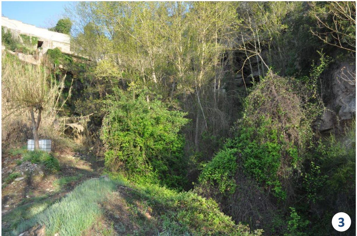
Espai entre un dels punts de desaigua de la Central Hidroelèctrica i la cinglera que fa de límit físic y natural de la parcel·la.
