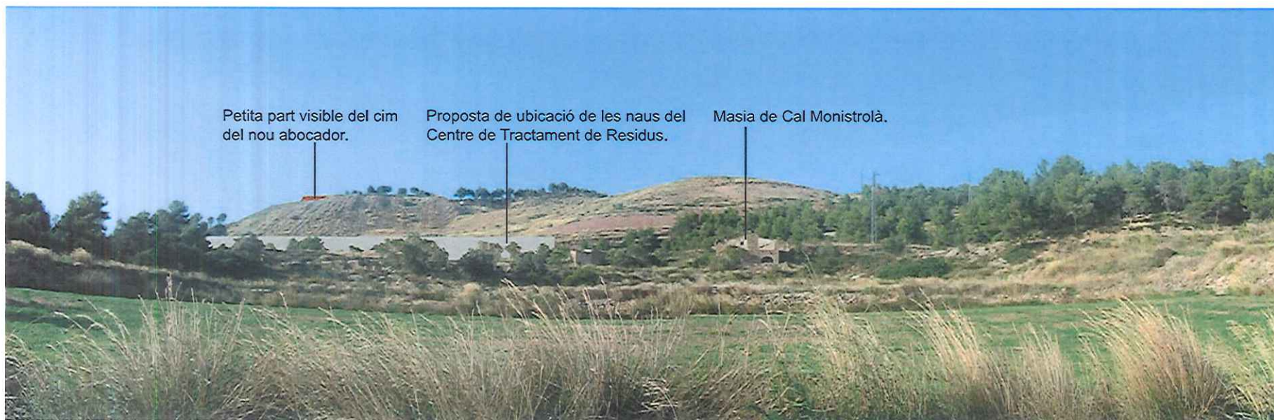
Vista amb la representació del nou abocador clausurat i les naus del Centre de Tractament de Residus.
