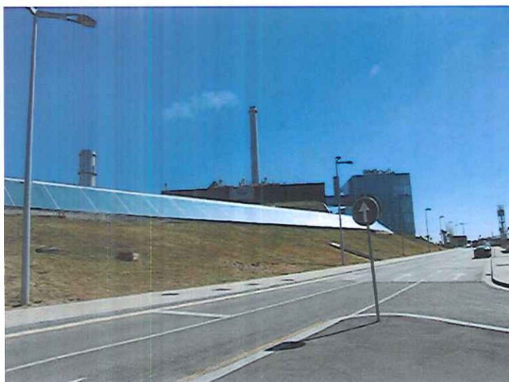
Planta de triatge i revalorització de residus, de l'Ecoparc 3, situada al Forum de Barcelona, amb talusos massa artificials.
