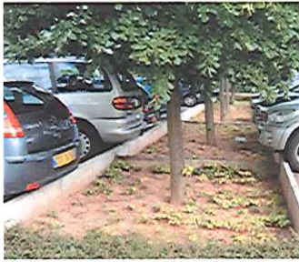
Exemple d'aparcament amb control i gestió de l'escolament de les aigües pluvials
