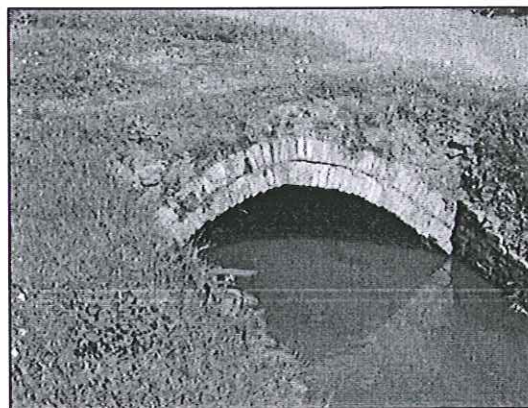
Foto 11. Pontarró (doble volta de maó)
