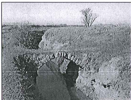
Foto 10. Pontarró (volta de pedra)
