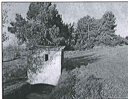
Foto 11. Pontarró (doble volta de maó)
