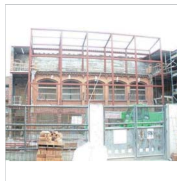
Façana principal durant les obres de reforma
