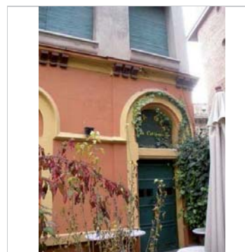
Detall de la façana principal
