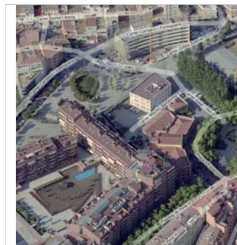
Detall de la façana principal
