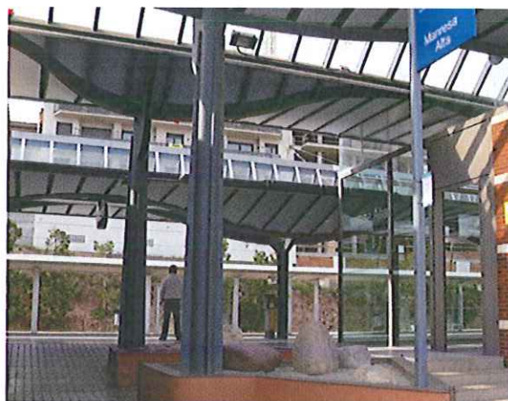
Estació Manresa – Alta. Accés adaptat a PMR
