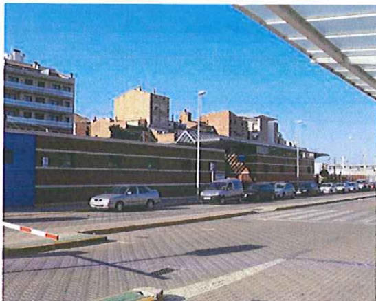
Estació Manresa - Alta
