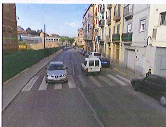
c. de St. Ignasi. Pas de vianants no rebaixat
