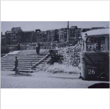
Les escales que salvaven el desnivell del pont Arxiu Comarcal del Bages
