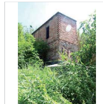
Construcció annexa a la resclosa
