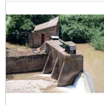
Construcció annexa a la resclosa
