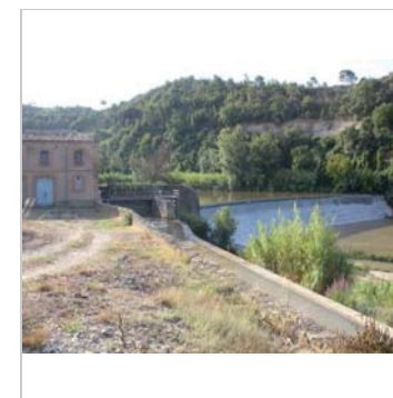
Resclosa, caseta de control i origen del canal
