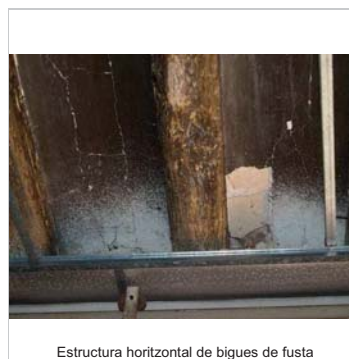
Estructura horitzontal de bigues de fusta
