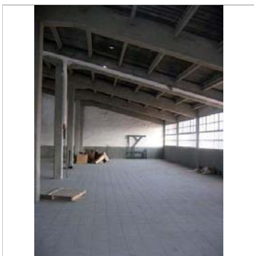
Interior de l'edifici
