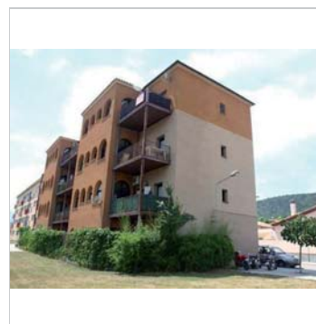
Bloc de PB+3 reconstruït el 1991
