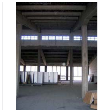
Interior de l'edifici
