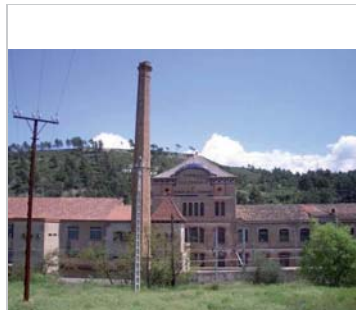
Façana principal de la fàbrica i xemeneia
