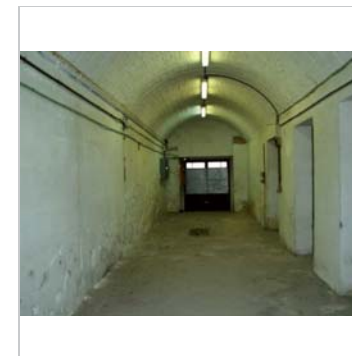
Interior amb volta de maó de pla
