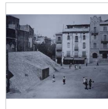
Exterior del refugi als anys quaranta Arxiu Comarcal del Bages
