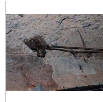
Detall instal·lació elèctrica original
