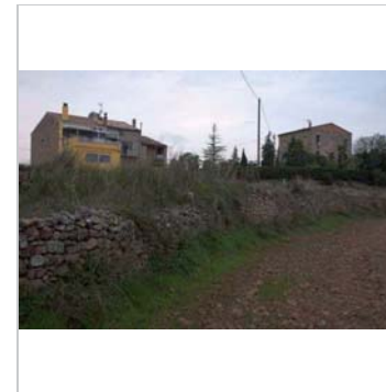
Fotografia dels murs
