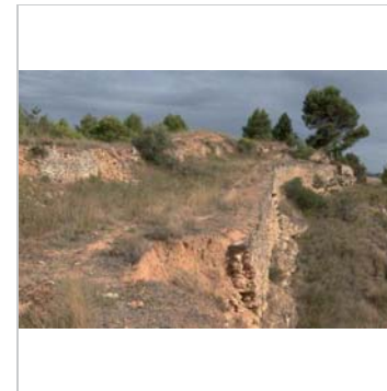
Fotografia dels murs
