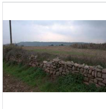
Fotografia dels murs
