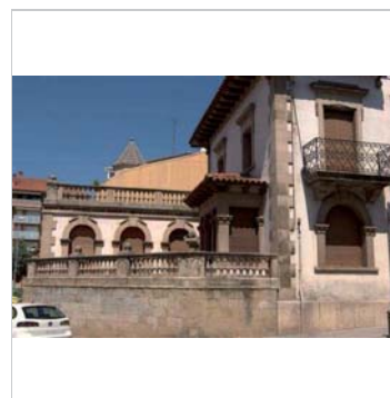
Detall de la façana
