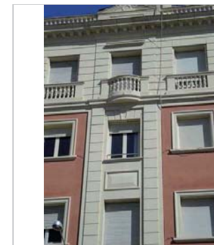
Detall de la façana
