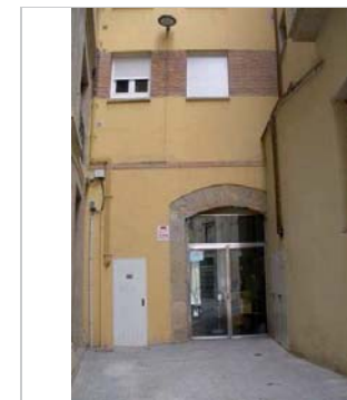
Porta amb arc rebaixat al c. de les Piques
